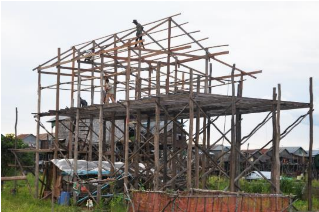
รูปที่ 52 โครงสร้างของเรือนเสาสูง
