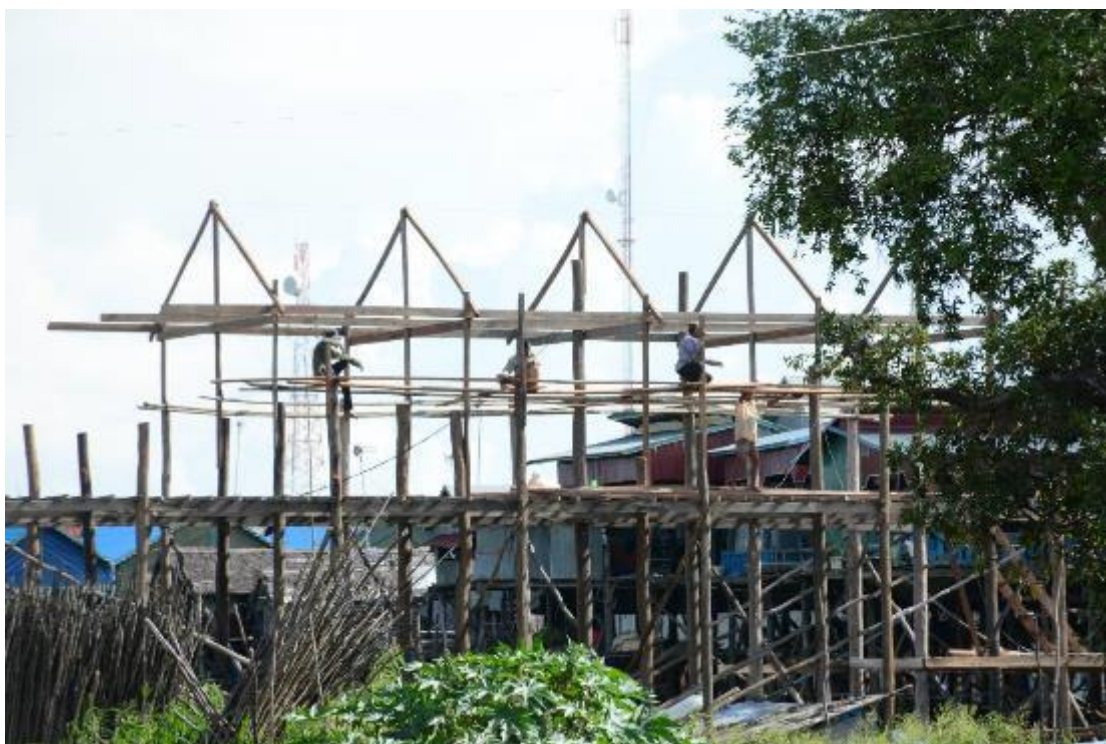
รูปที่ 49 ขั้นตอนการตั้งโครงสร้างหลังคา
