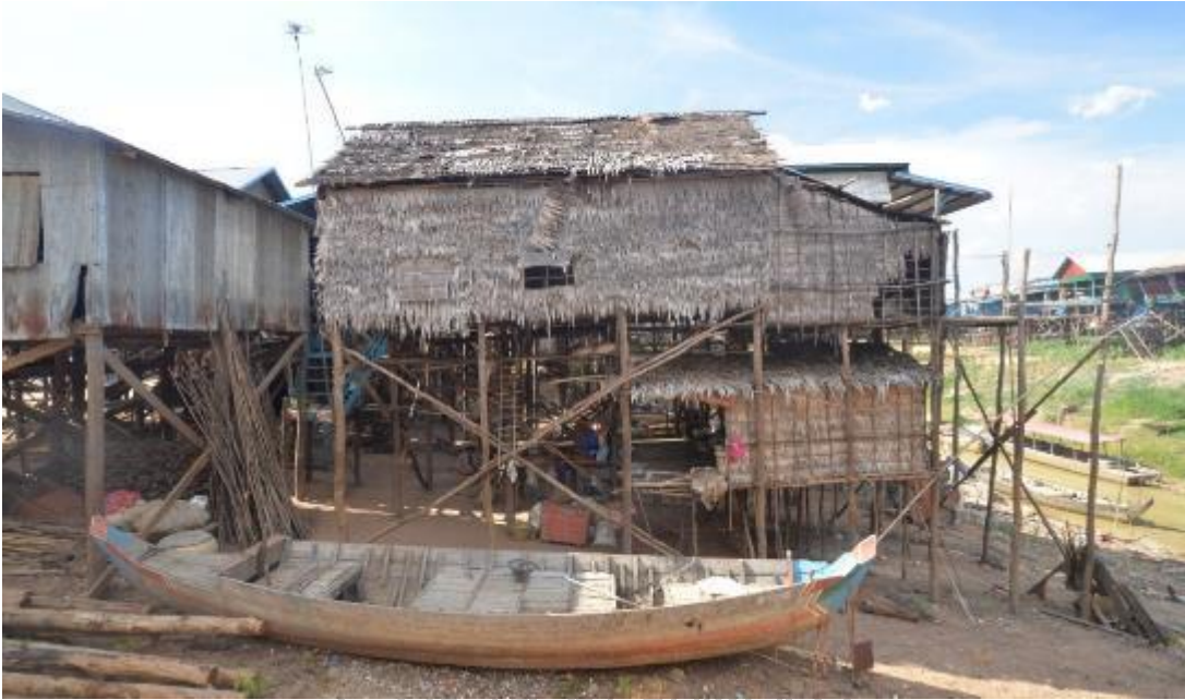
รูปที่ 40 วัสดุประเภทไผ่ตาล สำหรับใช้มุงผนังและหลังคา ซึ่งมีคุณสมบัติน้ำหนักเบาและอากาศถ่ายเทได้สะดวก เหมาะกับภูมิอากาศแบบร้อนชื้น
