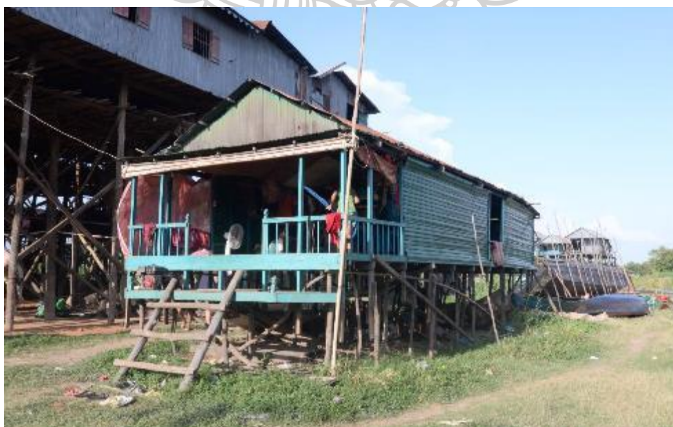
รูปที่ 54 เรือนลอยน้ำที่ถูกถอดโครงสร้างทุ่นลอยน้ำ เพื่อตั้งเรือนสำหรับอยู่อาศัยบนพื้นดิน
