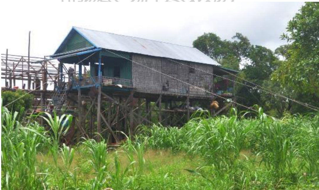
รูปที่ 53 เรือนเสาสูงที่มีการใช้เชือกขึงรัดตัวเรือนเพื่อเสริมความแข็งแรง เนื่องจากสร้างขึ้นบนที่โล่ง แยกห่างจากกลุ่มบ้านอื่นๆ ทำให้รับแรงปะทะจากลมทุกทิศทาง
