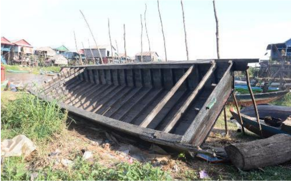
รูปที่ 55 โครงสร้างท่อนลอยน้ำแบบกระบะไม้ที่ถูกถอดออกจากเรือนลอยน้ำ
