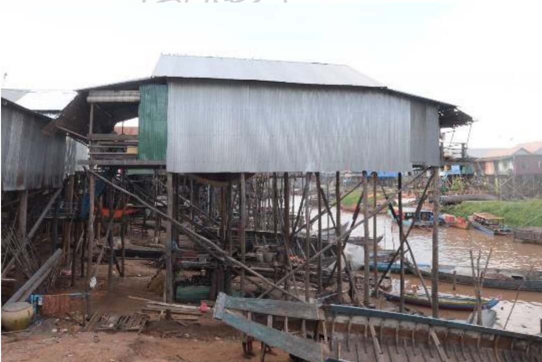
รูปที่ 41 การเปลี่ยนมาใช้วัสดุอุตสาหกรรมประเภทสังกะสี แม้ว่าจะรักษาคุณสมบัติความเบาของวัสดุไว้ได้ แต่ ก็สูญเสียคุณสมบัติการระบายความร้อน
