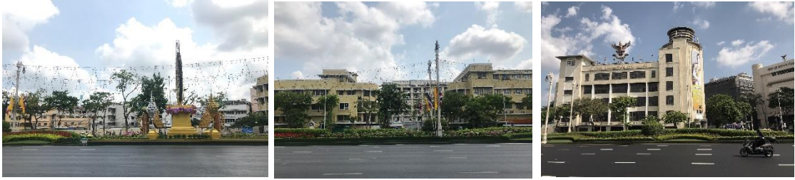
ภาพที่ 74 ส่วนโอบล้อมทางด้านทิศเหนือของถนนราชดำเนินกลาง
