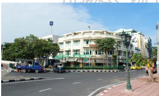
ภาพที่ 120 ส่วนโอบล้อมทางด้านทิศตะวันตกของลานปฐมบรมราชานุสรณ์ รัชกาลที่ 1 ส่วนโอบล้อมทางด้านทิศใต้ สะพานพุทธยอดฟ้าจุฬาโลกมหาราช
