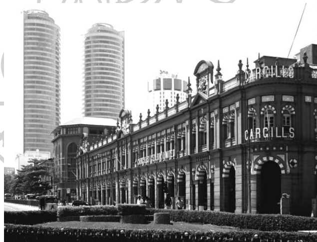
ภาพที่ 31 Cargills Department Store
