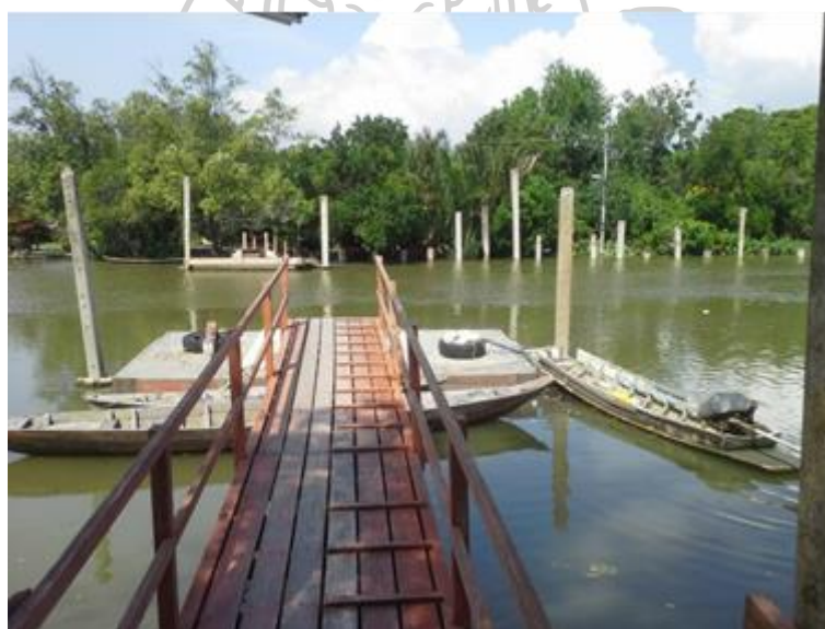
ภาพที่ 113 ท่าเทียบเรือชุมชนบ้านเขายี่สาร สามารถปรับระดับตามการขึ้น - ลงของน้ำ
