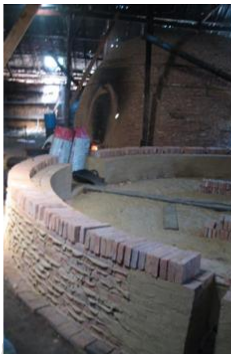
ภาพที่ 139 การก่อและเรียงอิฐผนังเตาเผาถ่าน การก่อจะเว้นในตำแหน่งปล่องควัน ถ่ายภาพโดย กุณชลทิพย์ พานิชภักดิ์, 2552
