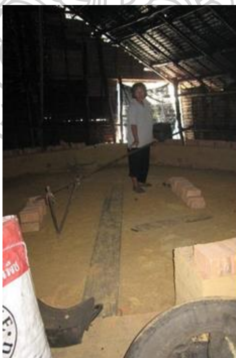
ภาพที่ 136 เครื่องมือที่ช่างก่อเตาใช้ในการกำหนดรัศมี และความโค้งของผนังเตาเผาถ่าน ถ่ายภาพโดย กุณชลทิพย์ พานิชภักดิ์, 2552
