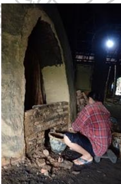
ภาพที่ 73 การก่อปิดหน้าเตาภายหลังการตั้งไม้แล้วเสร็จ
