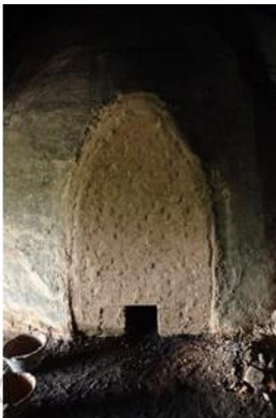
ภาพที่ 74 ใช้ดินจืดในการผสมอันธูแต่ละก้อนและฉาบผิวด้านนอกเว้นช่องสำหรับใส่เชื้อไฟ
