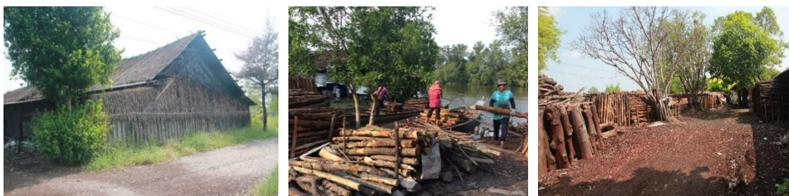
ภาพที่ 126 ลักษณะของโรงถ่านเป็นโรงเรือนยาว ปลูกสร้างติดลำน้ำเพื่อความสะดวกในการขนส่ง วัตถุดิบใน การผลิตถ่าน และจะมีพื้นที่สำหรับเรียงท่อนไม้โกงกางที่ด้านหน้าโรงถ่าน
