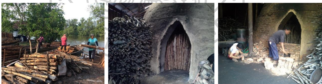
ภาพที่ 85 นำท่อนไม้หลากหลายจากแปลงปลูกมาทางเรือ เรียงใส่ในเตาซึ่งก็ต้องใช้ความชำนาญของคนที่จะเรียงไม้เพื่อให้ได้ปริมาณไม้มากที่สุดในการเผาแต่ละครั้งถ้าไม้ท่อนมีขนาดใหญ่จะใส่ได้ประมาณ 9,000 ท่อน ถ้าไม้มีขนาดเล็กจะใส่ได้ประมาณ 12,000 ท่อน จากนั้นก่ออิฐปิดประตูเตาเหลือเพียงช่องใส่ไฟ
