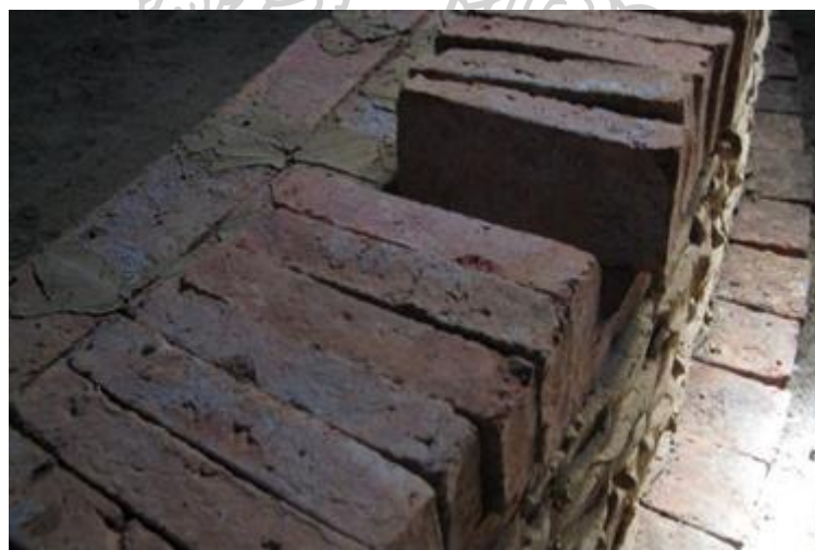
ภาพที่ 140 การก่อและเรียงอิฐผนังเตาเผาถ่าน ถ่ายภาพโดย กุณชลทิพย์ พานิชภักดิ์, 2552
