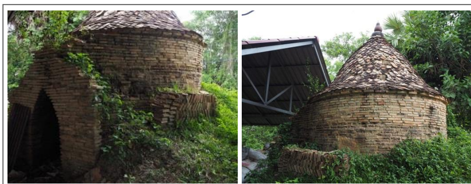
ภาพที่ 29 แสดงเตาเผากระเบื้องจำลองตามรูปแบบดั้งเดิม
