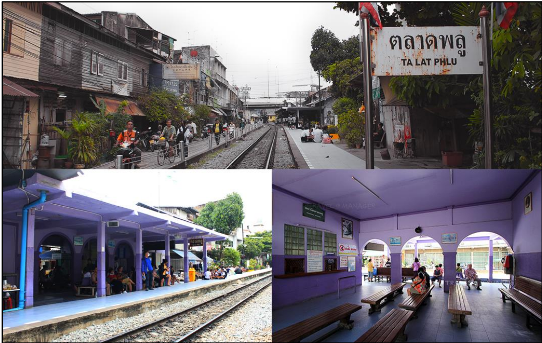
ภาพที่ 15 ลักษณะทางกายภาพของอาคารสถานีรถไฟ ตลาดพลู
