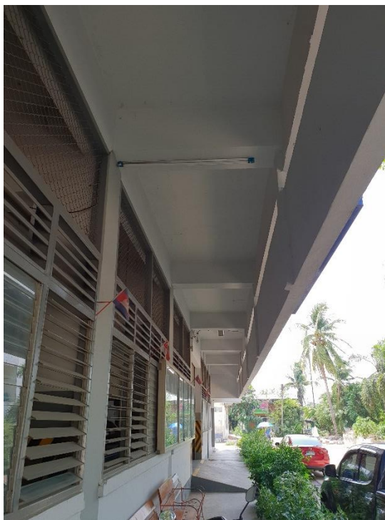
ภาพที่ 49 ลักษณะของกันสาดแนวนอนและแนวตั้งที่คลุมหน้าต่างของอาคารทุกชั้น
