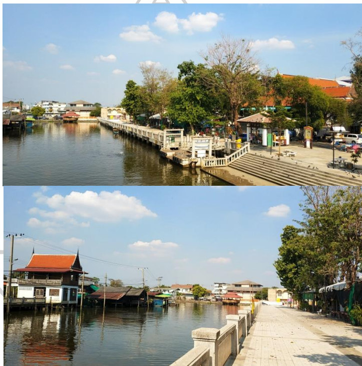
ภาพที่ 32 ถ่ายทางเดินริมน้ำและเขื่อนกันตลิ่งวัดชลอภายหลังการปรับปรุงแล้วเสร็จ (ภาพถ่าย ปี พ.ศ.2563)
