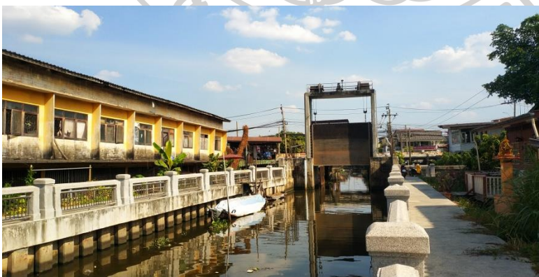
ภาพที่ 23 การปรับปรุงประตูน้ำวัดชลอ และการทำเขื่อนกันตลิ่งบริเวณวัดชลอเพื่อป้องกันผลกระทบ จากน้ำท่วมในปี พ.ศ.2554
