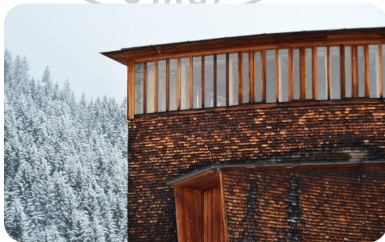
ภาพที่ 76 การเจาะช่องเปิดส่วนบนสุดของผนังเพื่อช่วยกระจายแสง
