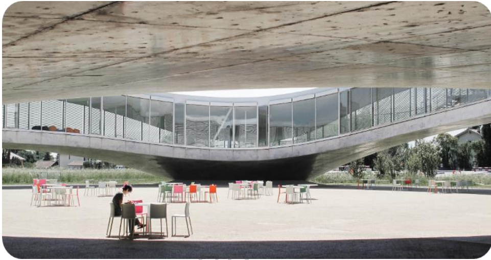
ภาพที่ 55 โครงสร้างของตัวอาคารที่มีบางส่วนยกตัวสูงขึ้นและลอยเหนือพื้นดิน
