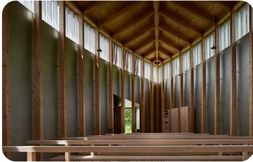
ภาพที่ 75 ลักษณะของโครงสร้างที่มีความต่อเนื่องและทำงานสัมพันธ์กันเป็นระบบ
