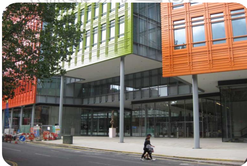
ภาพที่ 71 โครงสร้างของอาคารที่ใช้เสาลอยเพื่อให้ตัวอาคารสัมผัสพื้นดินน้อยที่สุด
