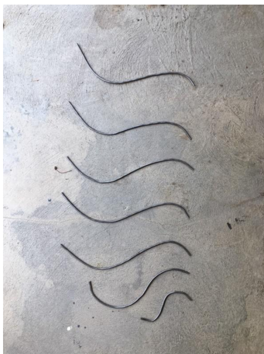
ภาพที่ 90 นำเหล็กเส้นมาตัดและเชื่อมเป็นส่วนขาของผลงานในทั้งส่วนของโครงสร้างและรายละเอียดของผลงาน
