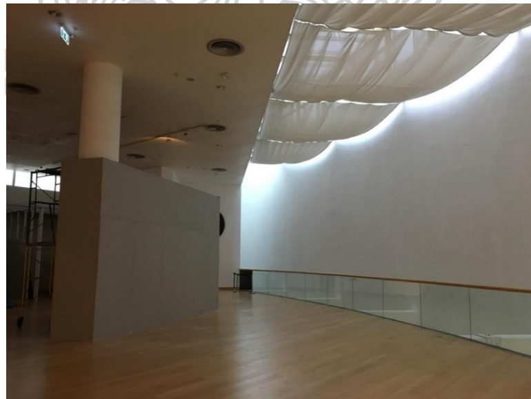
รูปที่ 55 การติดตั้งสติ๊กเกอร์ช่วยกันแสงธรรมชาติจากช่องแสงกลมและโครงสร้างผนังชั่วคราว
