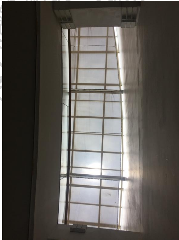
รูปที่ 48 ช่องแสงรับแสงธรรมชาติจากหลังคา แสงสามารถส่องผ่านม่านกรองแสง จาก ระเบียงติดต่อจากห้องนิทรรศการหลัก ชั้น 9 ถึงห้องนิทรรศการหลัก ชั้น 7 และชั้น 8
