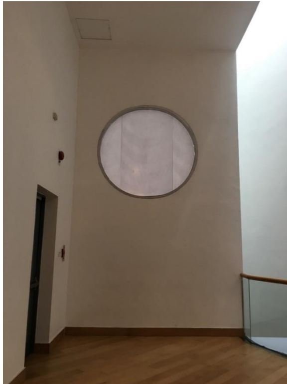
รูปที่ 54 การติดตั้งสติ๊กเกอร์เพื่อช่วยกันแสงธรรมชาติจากช่องแสงกลม ห้องนิทรรศการหลัก ชั้น 8
