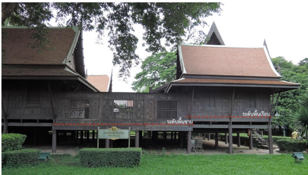
ภาพที่ 4 การยกใต้ถุนเรือนสูงเหนือระดับดิน ในพระตำหนักทับขวัญ จ.นครปฐม
