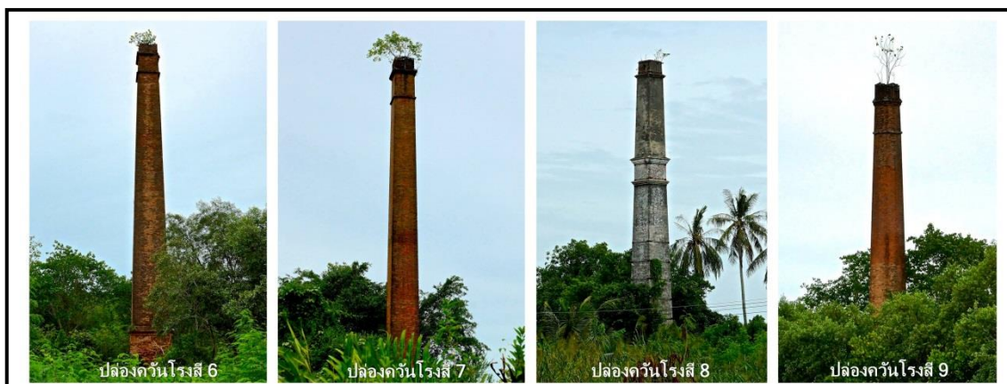
ภาพที่ 5. 5 โรงสีไฟฟ้าที่เกิดการทิ้งร้าง และยังคงมีปล่องควันโรงสีหลงเหลือให้เห็นอยู่
