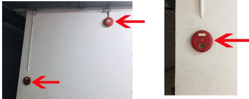
ก) มีระบบแจ้งเหตุเพลิงไหม้ด้วยมือ ภายนอกห้องปฏิบัติการ
