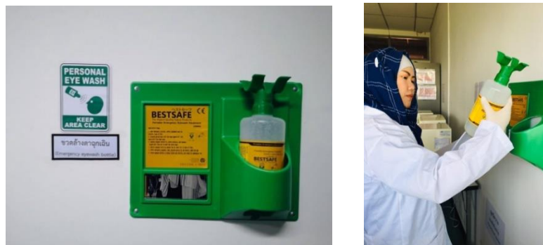
รูปที่ 4-24 ตรวจสอบเครื่องมือ/อุปกรณ์พร้อมตอบโต้ภาวะฉุกเฉิน
