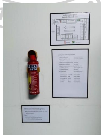
รูปที่ 4-19 สเปรย์ดับชนิดโฟมแบบเคลื่อนที่
