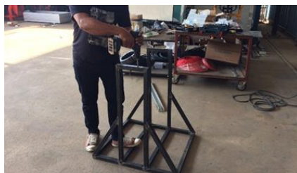
รูปที่ 47 ทำฐานตั้งชุดทดลอง
