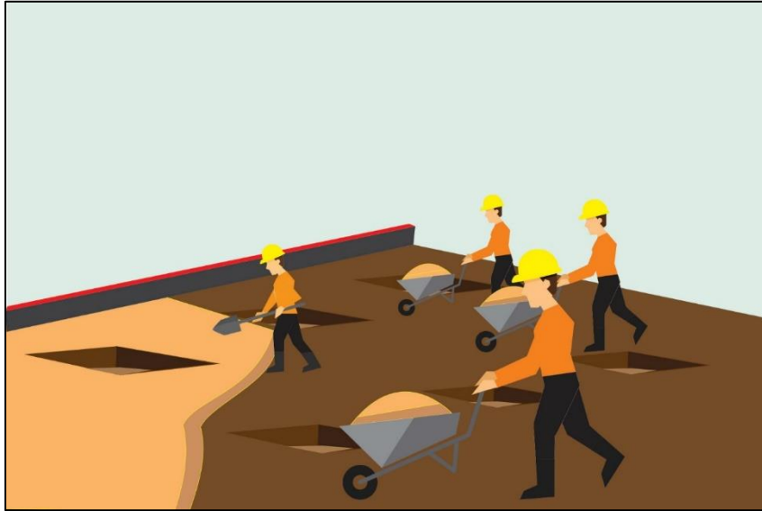
รูปภาพที่ 73 แสดงขั้นตอน แรงงานระดับล่างนำทรายมาปรับพื้น ทำการบดอัดทรายปรับพื้น ด้วยเครื่องตบดินหรือทุบให้แน่น
