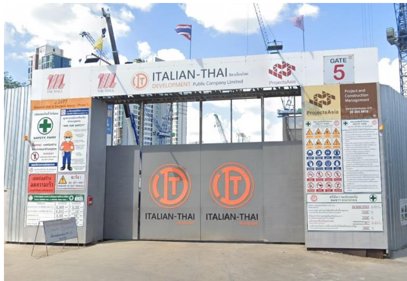
รูปภาพที่ 54 การนำป้ายเตือน 4 ภาษาไปใช้ในโครงการ Bangkok Mall
