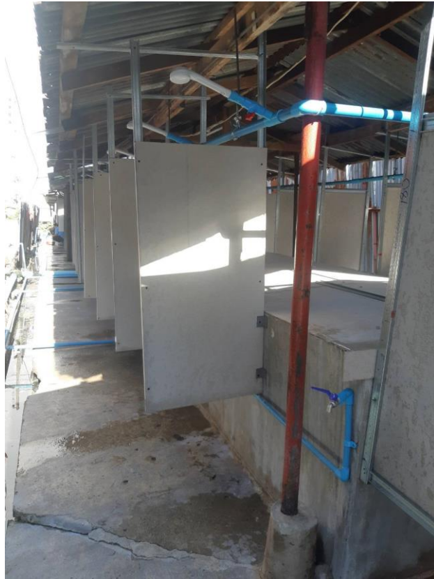
รูปภาพที่ 90 ติดตั้งฝักบัว และกั้นฉาก เพื่อป้องกันการแพร่กระจายเชื้อ
