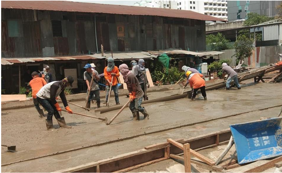
รูปภาพที่ 84 กั้นไม้แบบไม่แข็งแรงทำให้เกิดการบิดงอของแบบ หลังทดลองใช้แผนวิธีการก่อสร้าง ขั้นตอนการเตรียมงานเทพื้นคอนกรีต แสดงขั้นตอนอย่าง ง่ายเป็นรูปกราฟิก
