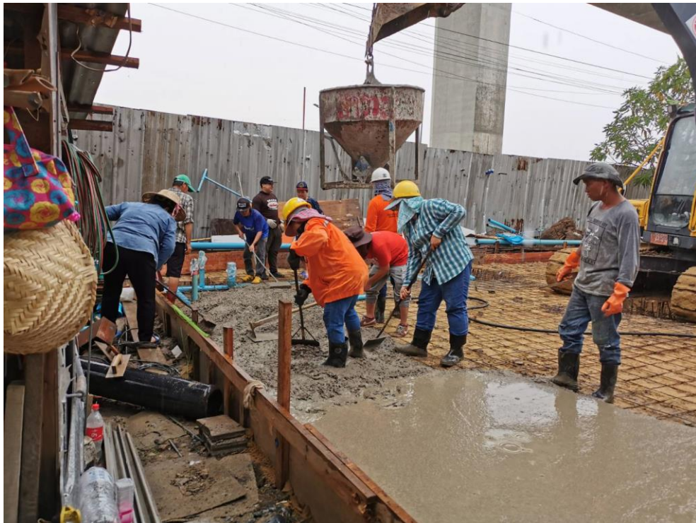
รูปภาพที่ 86 แรงงานกำลังเกลี่ยปูน
