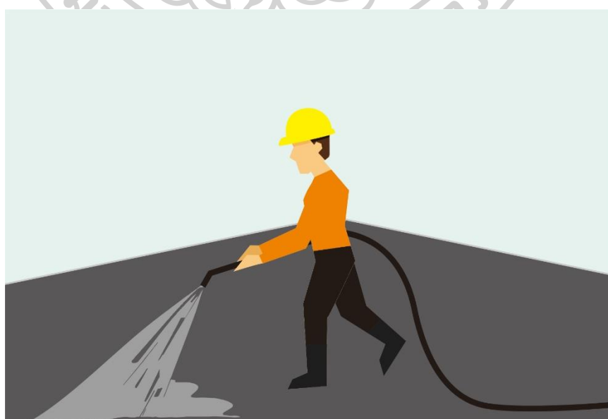
รูปภาพที่ 80 แสดงขั้นตอน แรงงานระดับล่างบ่มคอนกรีต ด้วยวิธีฉีบน้ำ
