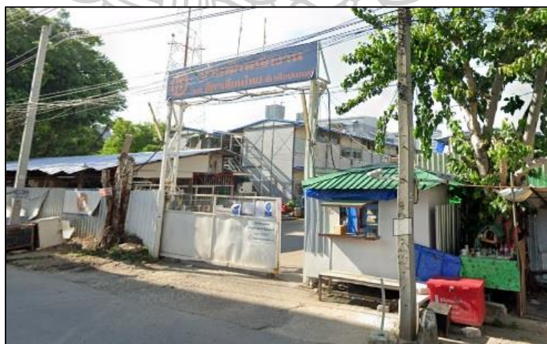
รูปภาพที่ 35 สภาพแวดล้อมบริเวณแคมป์ (อาคารสำเร็จรูป) 2 ชั้น
