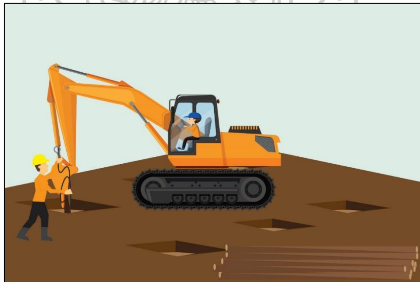
รูปภาพที่ 70 แสดงขั้นตอน รถแบคโฮกำลังกดเข็มไม้
