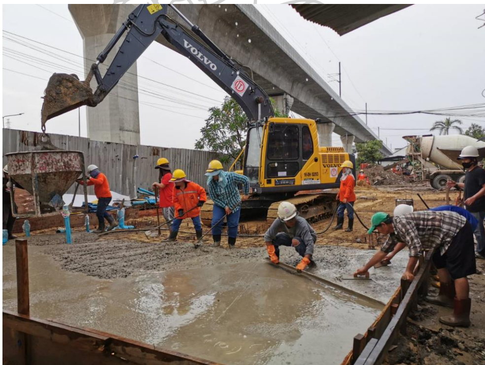
รูปภาพที่ 87 แรงงานใช้เกียงสามเหลี่ยมปาดปูน
