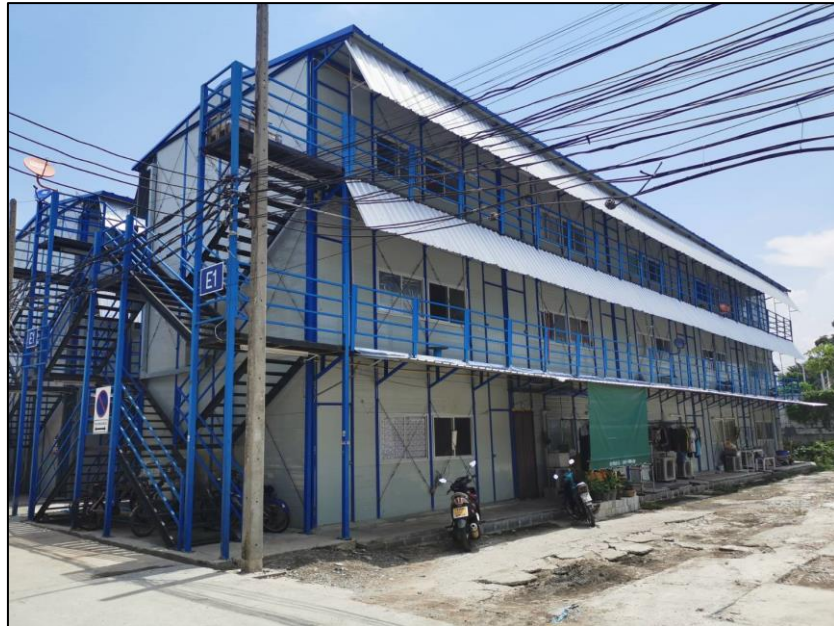
รูปภาพที่ 36 อาคารสำเร็จรูป 3 ชั้น
