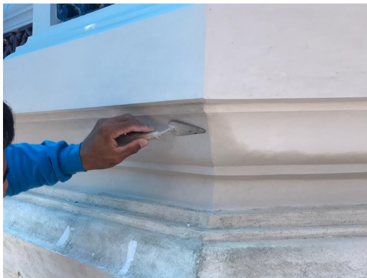
รูปภาพที่ 2 ช่างปูนงานลวดบัว
