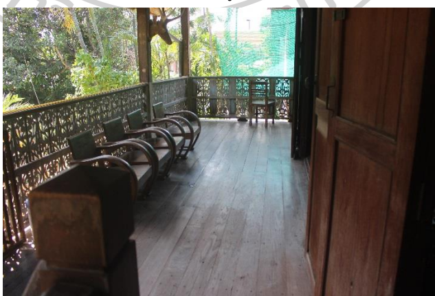
ภาพที่ 67 เสาและการปูพื้นบริเวณชั้นบน
