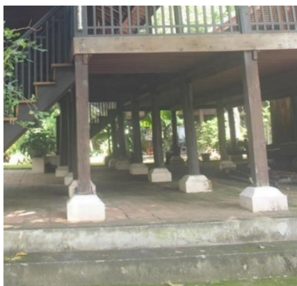
ภาพที่ 12 การวางเสารอบตัวเรือนและการถมพื้น
