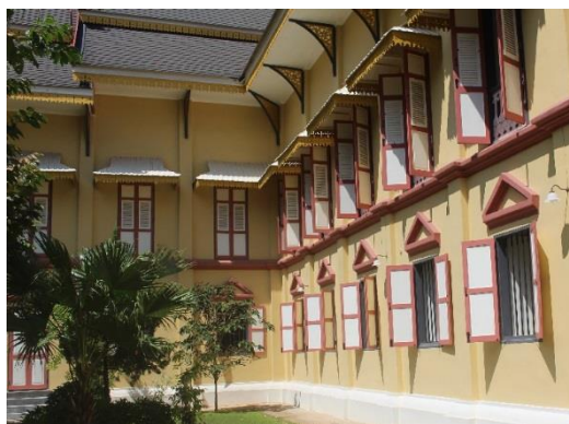
ภาพที่ 116 บานหน้าต่างชั้นล่างและชั้นบน
