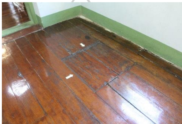
ภาพที่ 90 การปูพื้นด้วยไม้ บริเวณพื้นมีช่องสำหรับส่งของ
