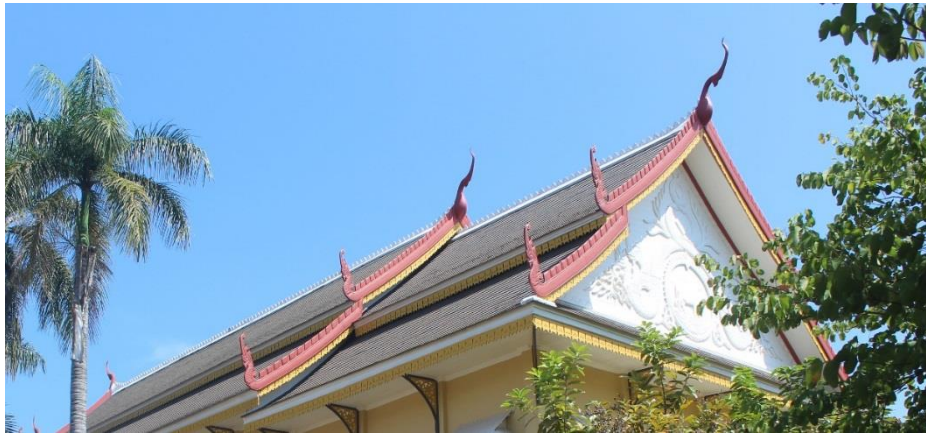
ภาพที่ 111 องค์ประกอบของเครื่องหลังคา
