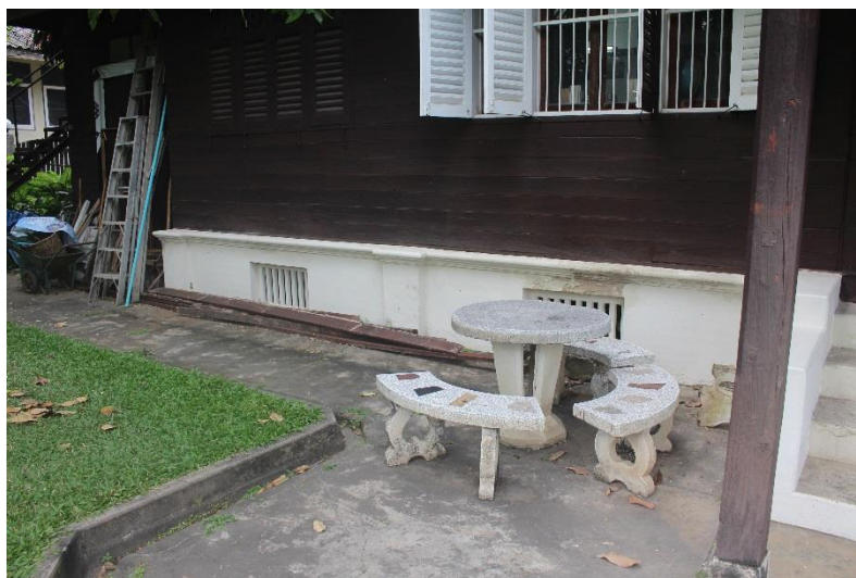
ภาพที่ 82 ส่วนฐานของเรือนที่ก่อด้วยอิฐและคอนกรีต
