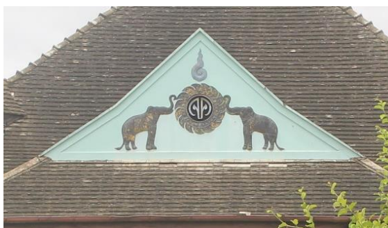
ภาพที่ 122 กระเบื้องซีเมนต์มุงหลังคา
