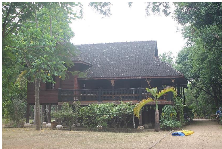
ภาพที่ 3 อาคารคุ้มบ้านทุ่งเสี้ยว อำเภอสันป่าตอง จังหวัดเชียงใหม่
