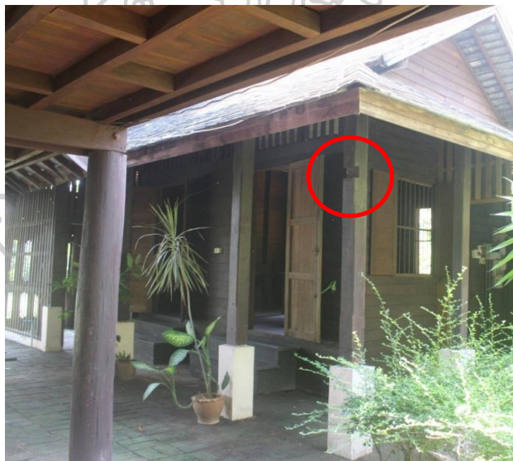
ภาพที่ 14 เสาที่ปรากฏร่องรอยของการถากไม้
