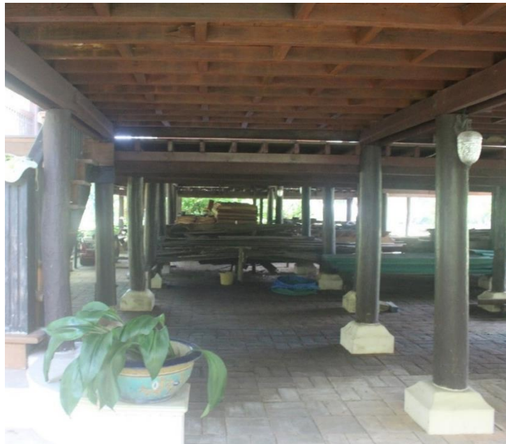
ภาพที่ 13 การวางเสาบริเวณใต้ถุน
