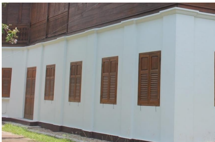
ภาพที่ 48 บ้านประตูและบานหน้าต่างบริเวณชั้นล่าง
