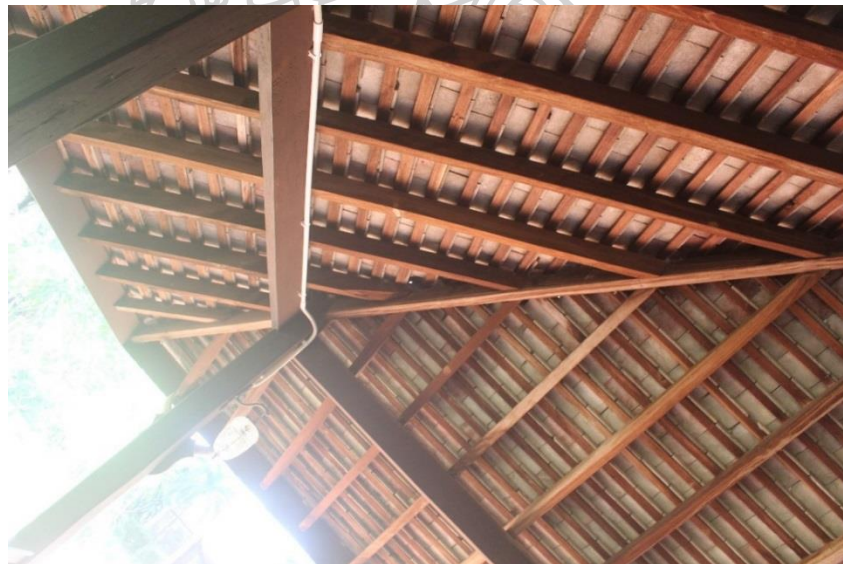
ภาพที่ 18 โครงสร้างหลังคาบริเวณต้นช่วงรอยต่อของหลังคาปีกนก
