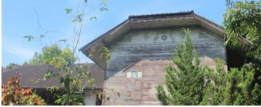
ภาพที่ 72 รูปแบบหลังคาหัวตัด
