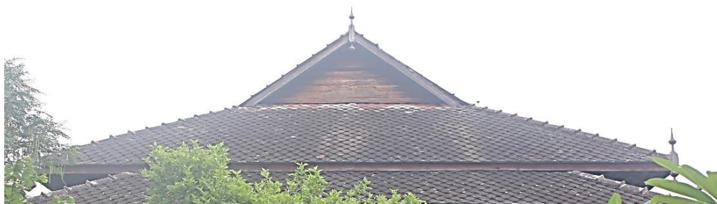
ภาพที่ 39 สรในประดับบริเวณมุมยอดจั่วและชายคา
