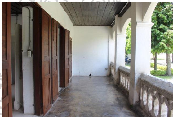
ภาพที่ 23 เสาและการปูพื้นบริเวณชั้นล่าง
