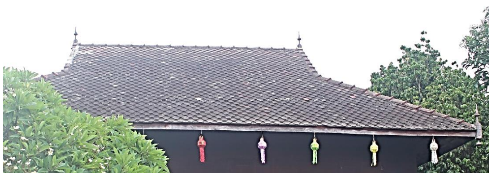
ภาพที่ 40 สรในประดับบริเวณมุมยอดจั่วและชายคา
