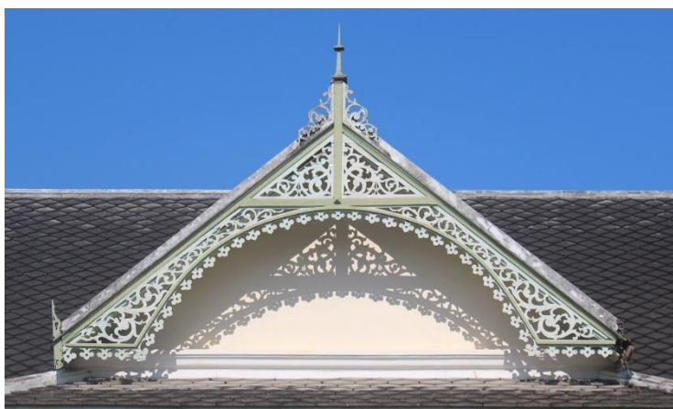
ภาพที่ 94 ลายฉลุบริเวณกรอบหน้าจั่วและเสากลึง
