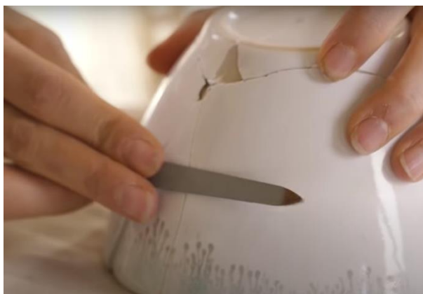
ภาพที่ 31 การใช้ตะไบละเอียดขัดเพื่อให้พื้นผิวบริเวณรอยต่อเรียบเนียน
