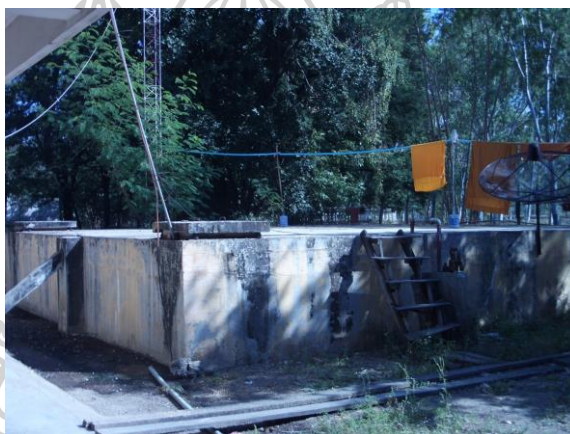
ถังเก็บน้ำฝน คอนกรีตเสริมเหล็ก ขนาดกว้าง 12.50x12.50x3.00 เมตร แล้วเสร็จเมื่อวันที่ 15 มิถุนายน 2521 ปัจจุบันไม่ได้ใช้เพราะนกพิราบมีมาก ทำให้น้ำสกปรกเพราะนกพิราบ
