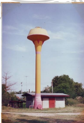
บ่อน้ำบาดาล 2 บ่อ หอถังจ่ายน้ำ 1 ลูก สร้างเมื่อ พ.ศ. 2522 แล้วเสร็จเมื่อวันที่ 15 พฤษภาคม พ.ศ. 2522 ปัจจุบันไม่ได้ใช้ เพราะมีน้ำประปามาถึงสระกระโจมแล้ว
