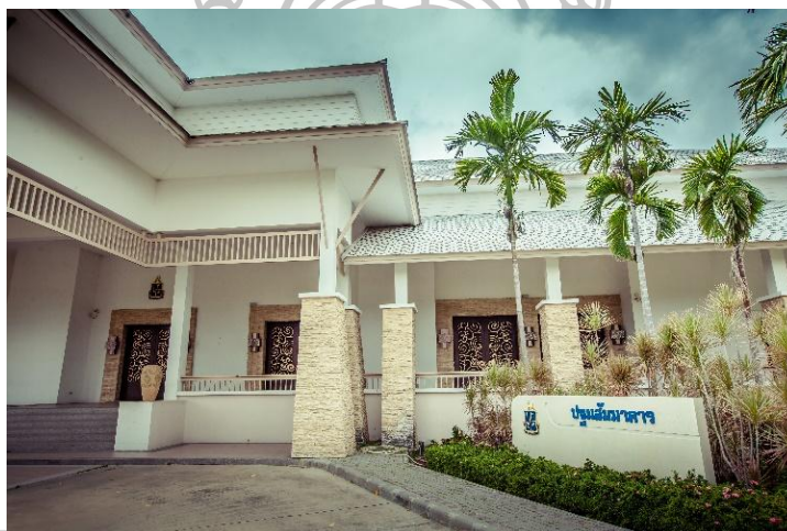
รูปภาพที่ 2.11 อาคารปฐมสยามาคาร
