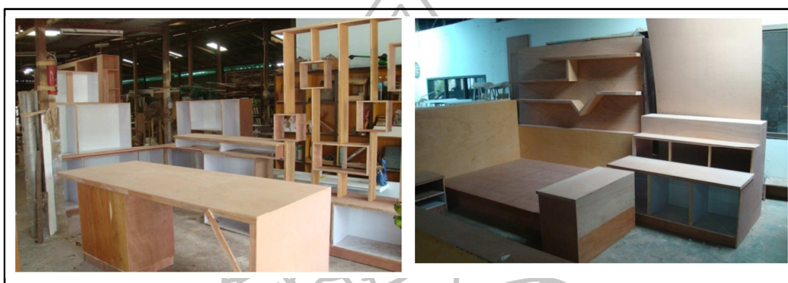
ภาพที่ 4 การขึ้นโครงสร้างงานไม้ของเฟอร์นิเจอร์
