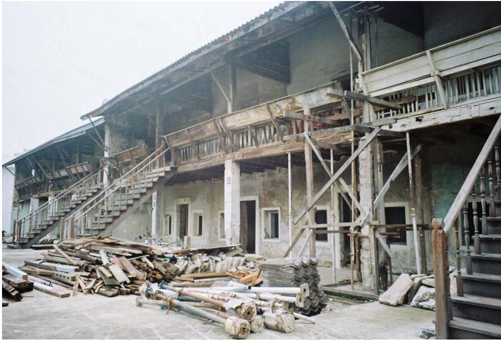
ภาพที่ 2. 13 ฮวยจุงโล้งก่อนซ่อมแซม
