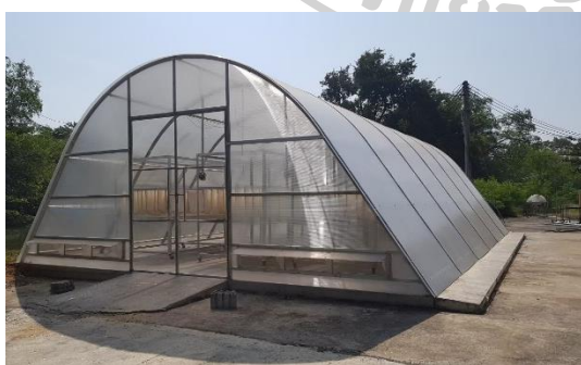
รูปที่ 61 การทดลองอบแห้งยางพาราแผ่นดิบ ด้วยเครื่องอบแห้งพลังงานแสงอาทิตย์แบบพาราโบลา โดมต้นแบบที่ มหาวิทยาลัยศิลปากร จังหวัดนครปฐม
