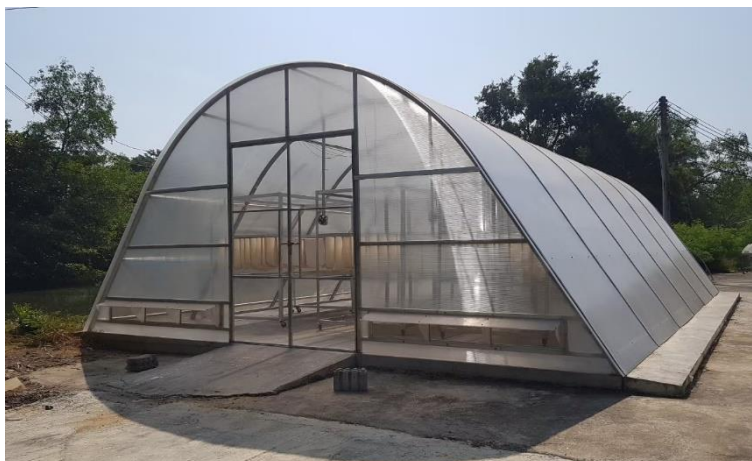
รูปที่ 31 ลักษณะโครงสร้างของเครื่องอบแห้งพลังงานแสงอาทิตย์แบบพาราโบลา
