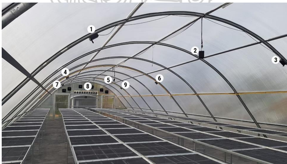
รูปที่ 41 การติดตั้งชุดเซนเซอร์วัดอุณหภูมิและความชื้นสัมพัทธ์ของอากาศภายในเครื่องอบแห้ง
