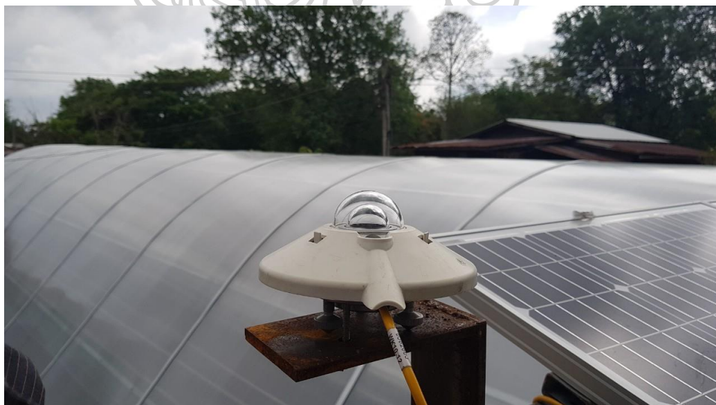
รูปที่ 58 การติดตั้งไพราโนมิเตอร์บนหลังคาเครื่องอบแห้ง เพื่อวัดความเข้มรังสีอาทิตย์
