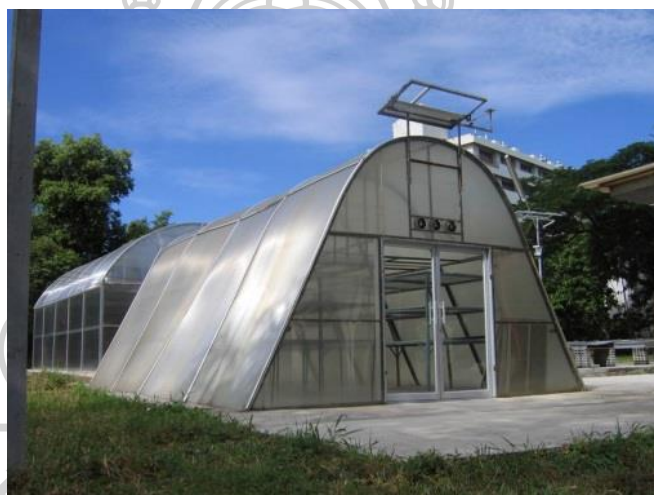
รูปที่ 22 ลักษณะภายนอกของเครื่องอบแห้งแบบเรือนกระจกรุ่นที่ 1 (Janjai et al., 2005)
