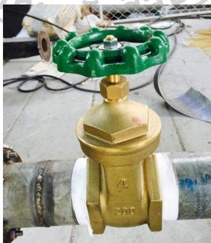
รูปที่ 3.10 เกทวาล์ว (Gate valve)
