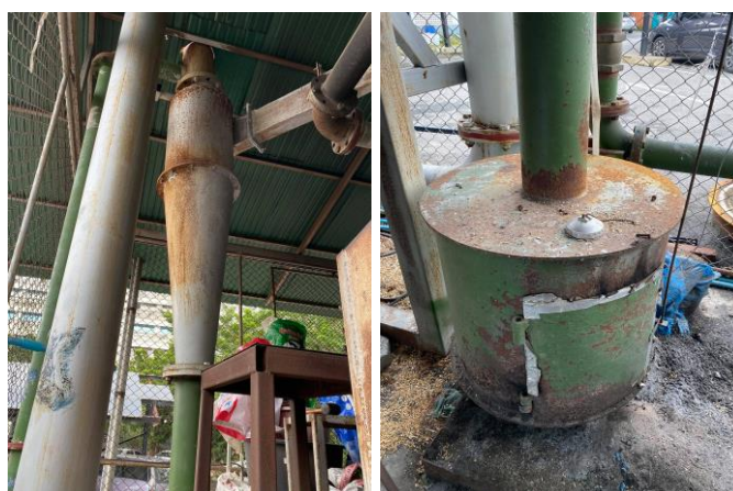
รูปที่ 3.8 แสดงลักษณะด้านบนและด้านล่างของไซโคลนดักฝุ่น (Cyclone Collector)
