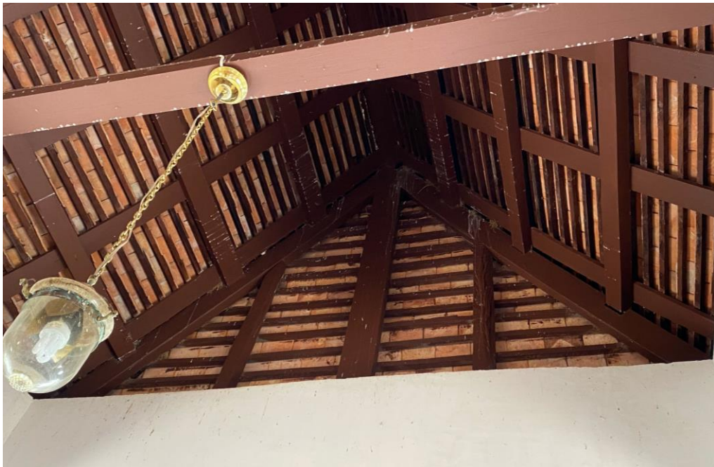
ภาพที่ ๒๑๔ เทคนิคการใช้ไม้ระแนงบนหน้าบันร่วมกับการฉาบปูนในอุโบสถวัดสามกอง
