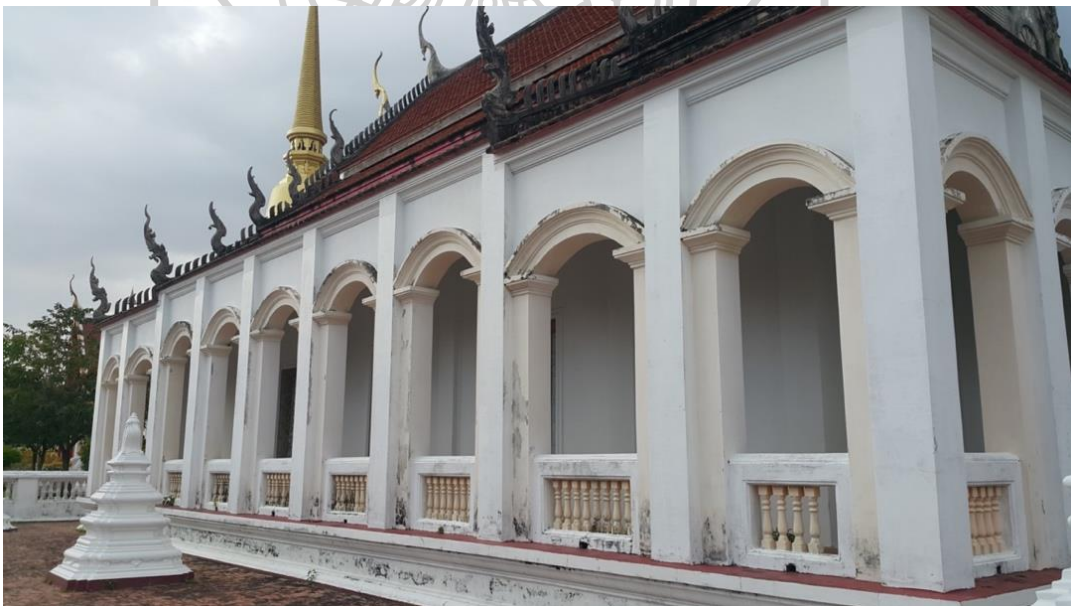
ภาพที่ ๑๘๖ รูปแบบช่องเปิดเสาพาไลของอุโบสถวัดสระเกษ
