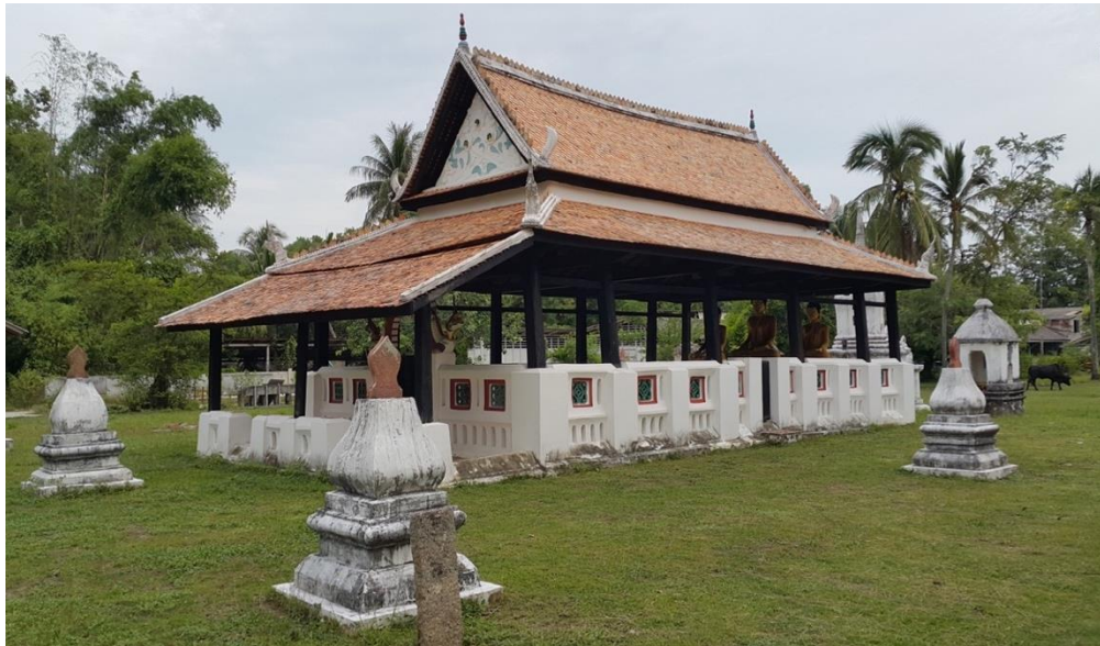
ภาพที่ ๒๐๖ ตัวอย่างอุโบสถทรงโครงสร้างเสาไม้วัดสนามชัย จังหวัดสงขลา
