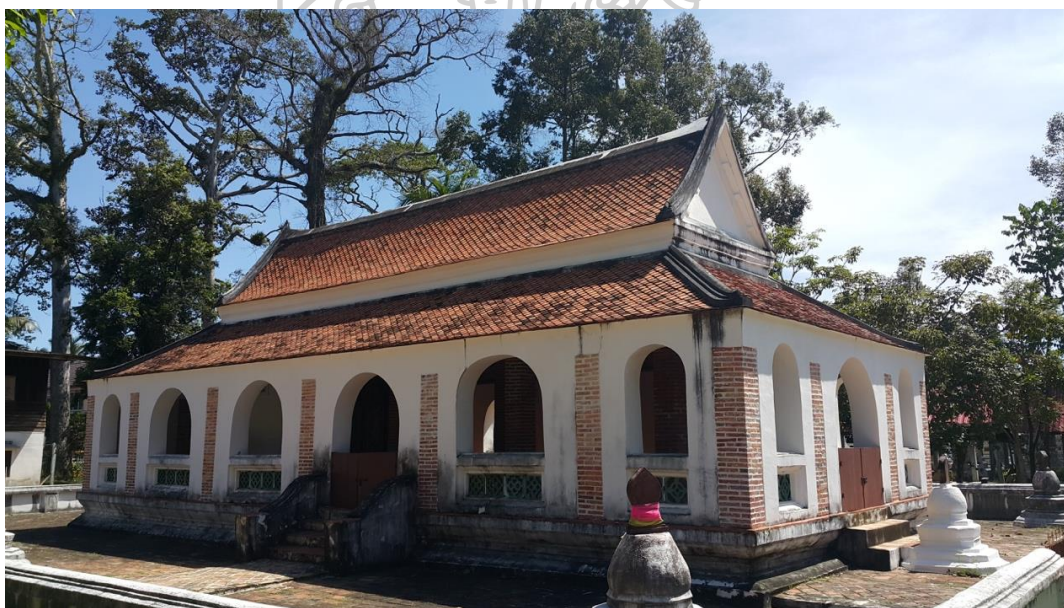
ภาพที่ ๒๑๒ อุโบสถโถงเสาก่ออิฐถือปูนวัดสามกอง จังหวัดสงขลา
