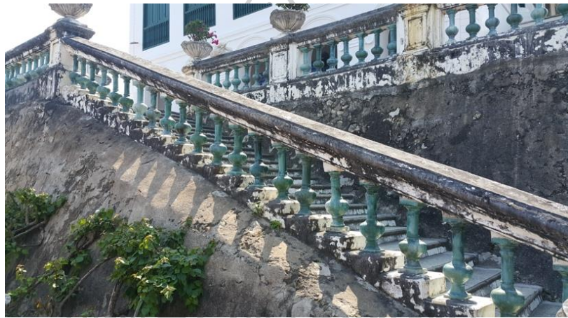
ภาพที่ ๑๗๘ พนักกระเบื้องและราวบันไดประดับลูกกรงกระเบื้องเคลือบแจกันทรงสูงบนพระนครคีรี จังหวัดเพชรบุรี
