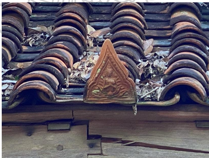
ภาพที่ ๒๑๑ กระเบื้องกาบู่และกระเบื้องเชิงชายของอุโบสถวัดแดง อำเภอหัวไทร จังหวัดนครศรีธรรมราช
