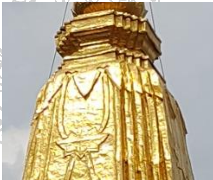
ภาพที่ ๖๑ บัวคอเสื้อบนเจดีย์ทรงเครื่องด้านหน้าปราสาทพระเทพบิดร วัดพระศรีรัตนศาสดาราม
