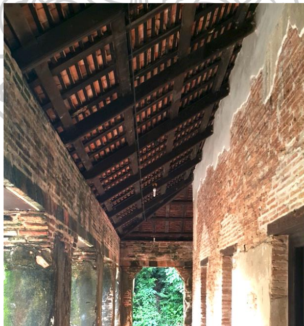
ภาพที่ ๑๖๐ ระบบโครงสร้างด้านในหลังคาปีกนกของอุโบสถวัดศิริวนาวาส
