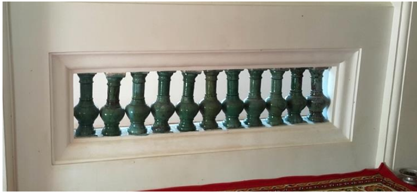
ภาพที่ ๑๗๗ พนักกระเบื้องประดับลูกกรงกระเบื้องเคลือบแจกันทรงสูงภายในอุโบสถวัดคูเต่า
