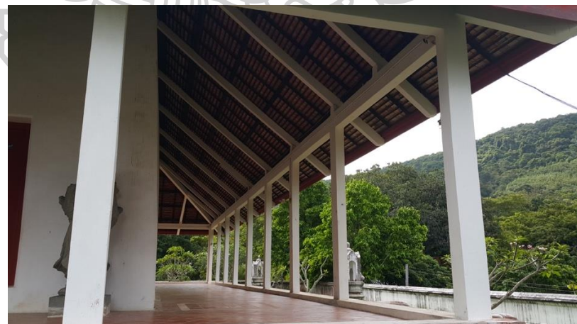
ภาพที่ ๑๑๔ เสาพาไลคอนกรีตเสริมเหล็ก (จากการบูรณะในปัจจุบัน) ของอุโบสถวัดสุวรรณคีรี
