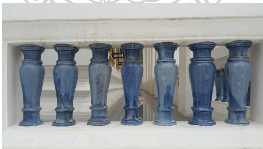
ภาพที่ ๑๗๙ พนักกระเบื้องประดับลูกกรงกระเบื้องเคลือบแจกันทรงสูงรอบพระอุโบสถวัดปทุมวนาราม กรุงเทพฯ
