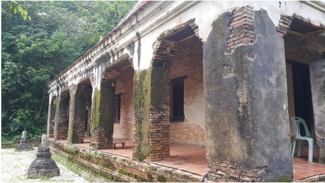
ภาพที่ ๑๕๗ รูปแบบและโครงสร้างเสาพาไลแบบช่องเปิดรูปสี่เหลี่ยมคางหมูของอุโบสถวัดศิริวนาวาส
