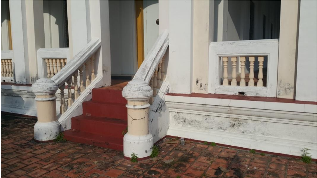
ภาพที่ ๑๘๗ พนักกระเบื้องประดับด้วยลูกกรงปูนหล่อพิมพ์ทรงแจกันทรงสูง วัดสระเกษ
