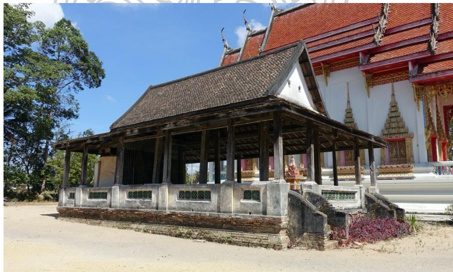
ภาพที่ ๒๐๕ ตัวอย่างอุโบสถโถงโครงสร้างเสาไม้วัดอู่ตะเภา จังหวัดสงขลา
