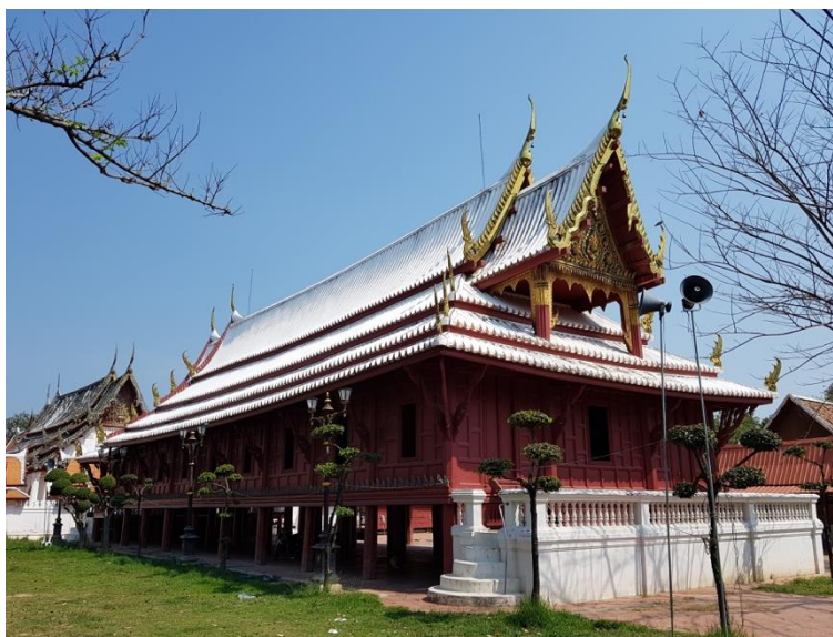
ภาพที่ ๔๓๓ ตัวอย่างอาคารหลังคาคลุมสมัยอยุธยาตอนปลายที่ทำมุขประเจิดที่ศาลาการเปรียญ วัดใหญ่สุวรรณาราม จังหวัดเพชรบุรี
