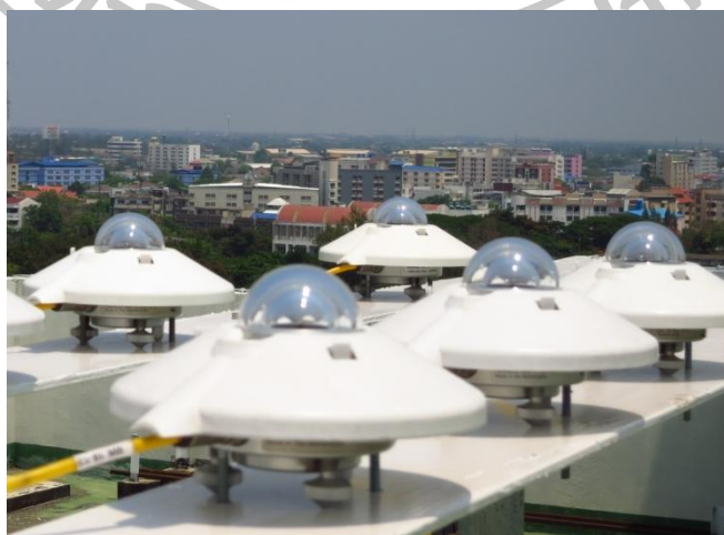
รูปที่ 3.35 การติดตั้งไพรานมิเตอร์ที่จะทำการสอบเทียบ
