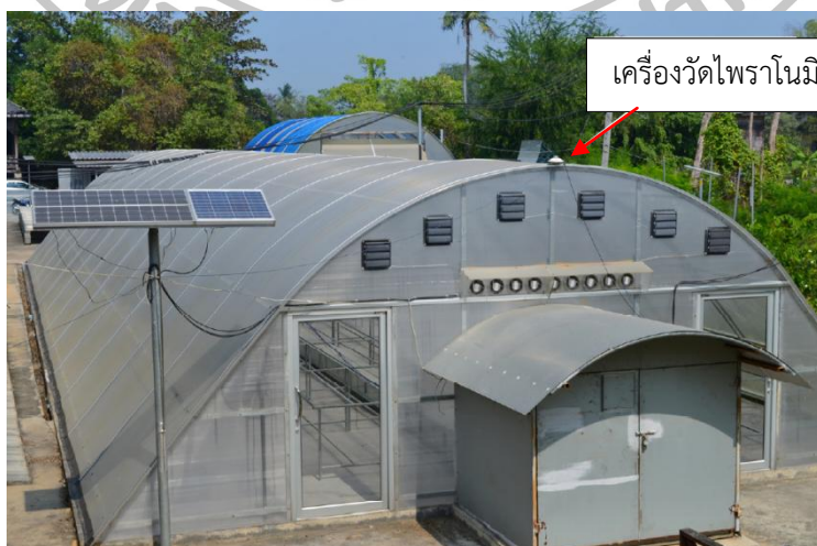
รูปที่ 2.4 การวัดรังสีอาทิตย์เพื่อประเมินสมรรถนะของระบบอบแห้งพลังงานแสงอาทิตย์ที่มหาวิทยาลัยศิลปากร จังหวัดนครปฐม
