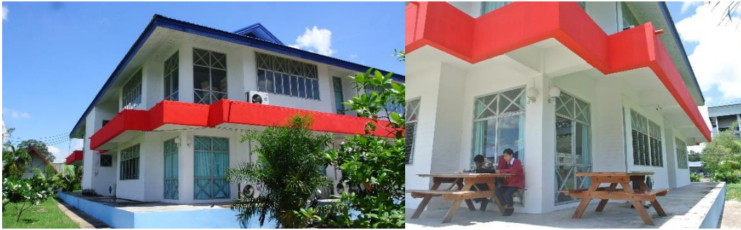
ภาพที่ 34 อุปกรณ์บังแดดของอาคารศูนย์วิทยบริการ วิทยาลัยเทคนิคศรีสะเกษ
