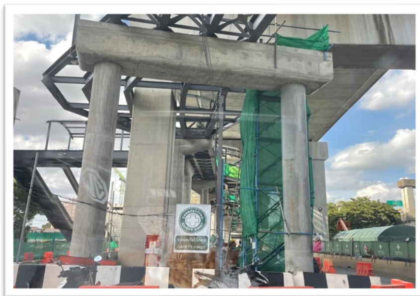
ภาพที่ 2 ภาพการก่อสร้างต่อเติมบริเวณถนนเรียบทางโครงการไฮโปเวลล์ ถนนวิภาวดีรังสิต ถ่ายโดยผู้วิจัยสร้างสรรค์ เมื่อ 10 พฤษภาคม 2565
