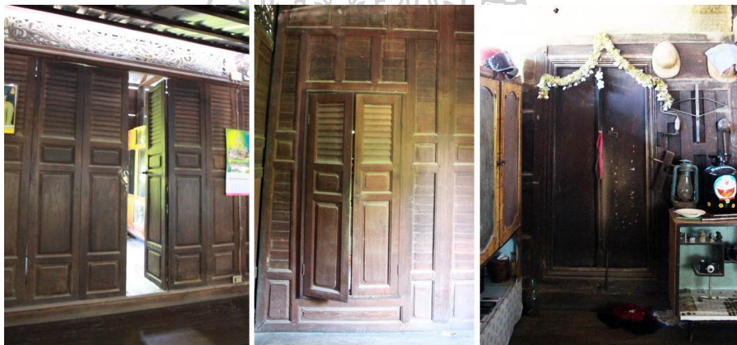
ภาพที่ 161 ซ้าย: ประตูทางเข้าในผนังเรือนประธาน กลาง: ประตูทางเข้าห้องนอนแบบเปิดคู่
