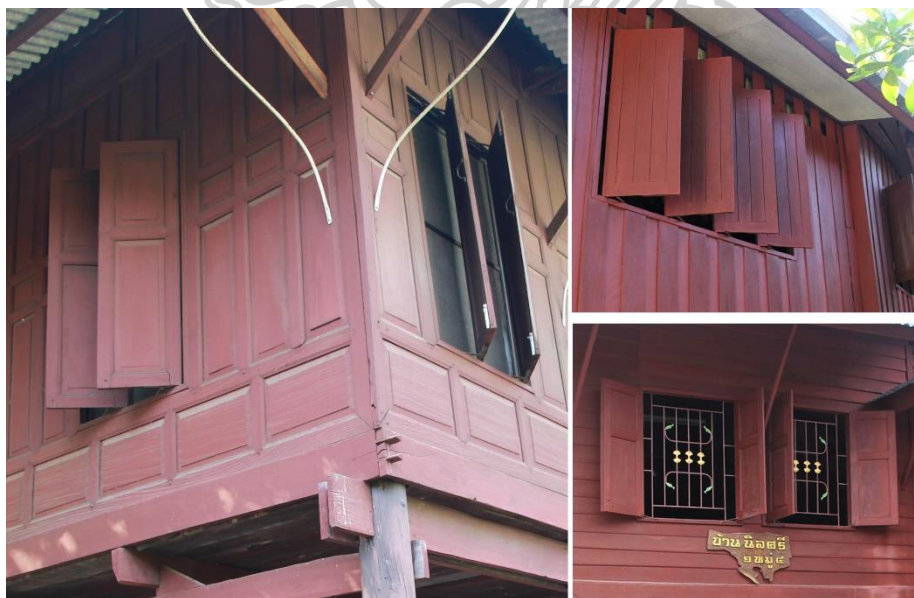
ภาพที่ 160 ซ้าย: หน้าต่างเปิดคู่ฝาดั้งแบบลูกฝักใหญ่รูปแบบที่ 2 ขวาบน: หน้าต่างแบบเปิดชุด 4 บาน ขวาล่าง: หน้าต่างแบบเปิดคู่ชนิดเปิดออกนอก
