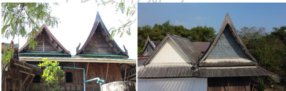
ภาพที่ 153 ภาพแสดงจั่วหลังคาของเรือนในกลุ่มที่ 2 ซ้าย:เรือนวางตามตะวัน ขวา:เรือนวางขวางตะวัน
