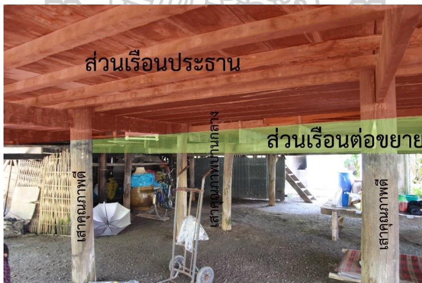
ภาพที่ 155 เสาเรือนประธานและเสาสำหรับเรือนต่อขยายใช้ผสมกันระหว่างเสาคุณภาพสวยงามกับเสาที่เล็กลงและสวยงามน้อยกว่าเสาเรือนประธาน
