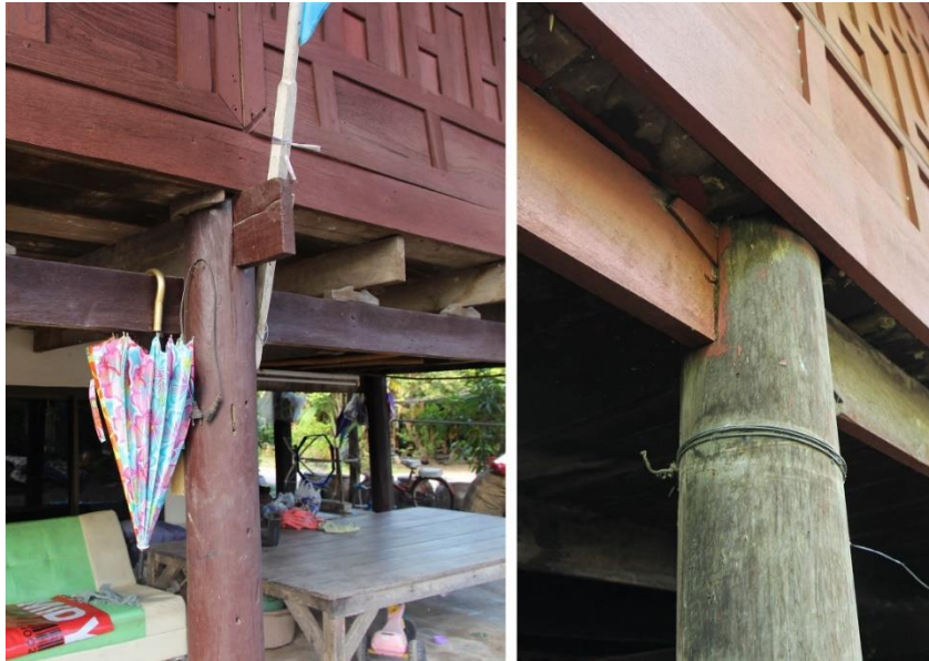
ภาพที่ 154 เสาของเรือนประธานจะใช้เสากลมเส้นผ่าศูนย์กลาง 25-30 ซม. เป็นเสาที่มีลักษณะสวยงามดูแข็งแรง
