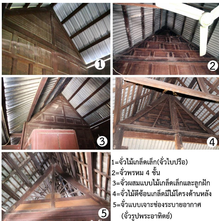
ภาพที่ 165 ภาพแสดงรูปแบบหน้าจั่วเรือน 4รูปแบบที่พบในเรือนกรณีศึกษา
