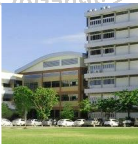
ภาพที่ 9 ทิศตะวันตก (ด้านข้างอาคาร) ติดกับ โรงอาหาร
