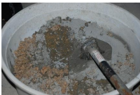
รูปที่ 126 แสดงการคลุกเคล้าส่วนผสมคอนกรีตให้เข้ากัน
