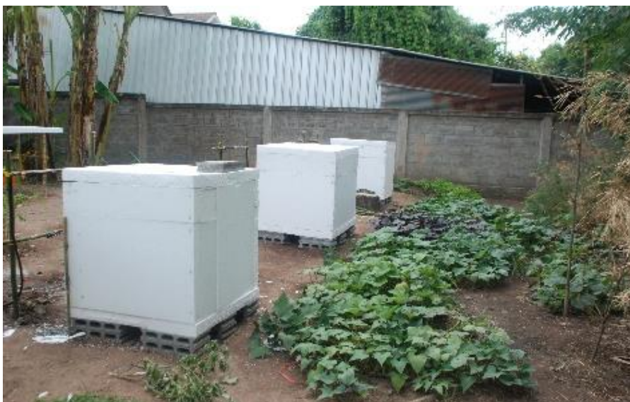
รูปที่ 182 แสดงด้านหลังของกล่องทดสอบที่สร้างแล้วเสร็จ 2
