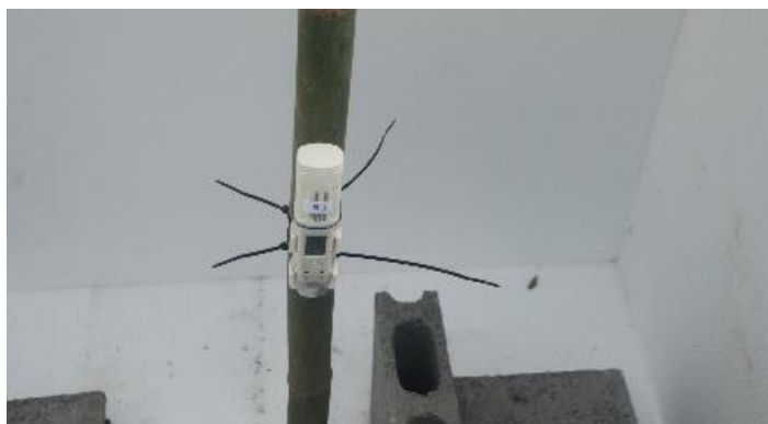
รูปที่ 189 แสดงการติดตั้งเครื่องตรวจวัดอุณหภูมิและความชื้นแล้วเสร็จ
