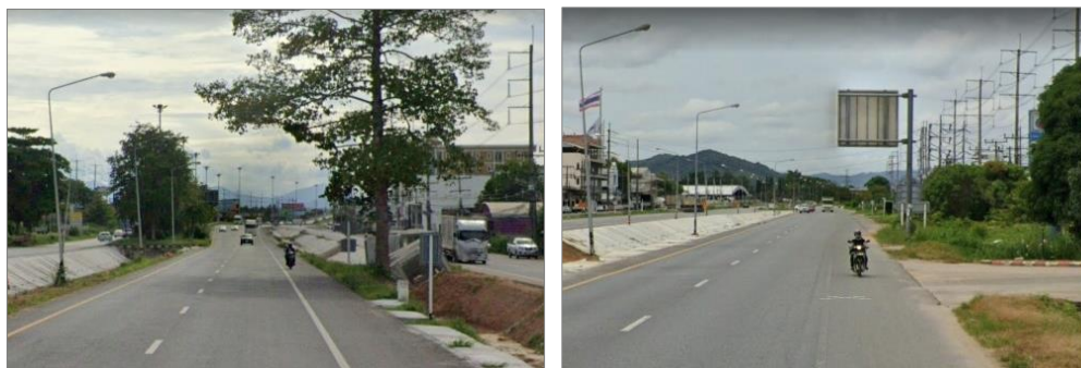
ภาพที่ 23 แสดงลักษณะถนนทางหลวงแผ่นดินหมายเลข 43
