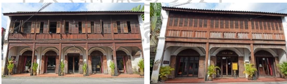
รูปที่ 6.3 แสดงอาคารเพื่อการพาณิชย์กรรม ห้องแถว
