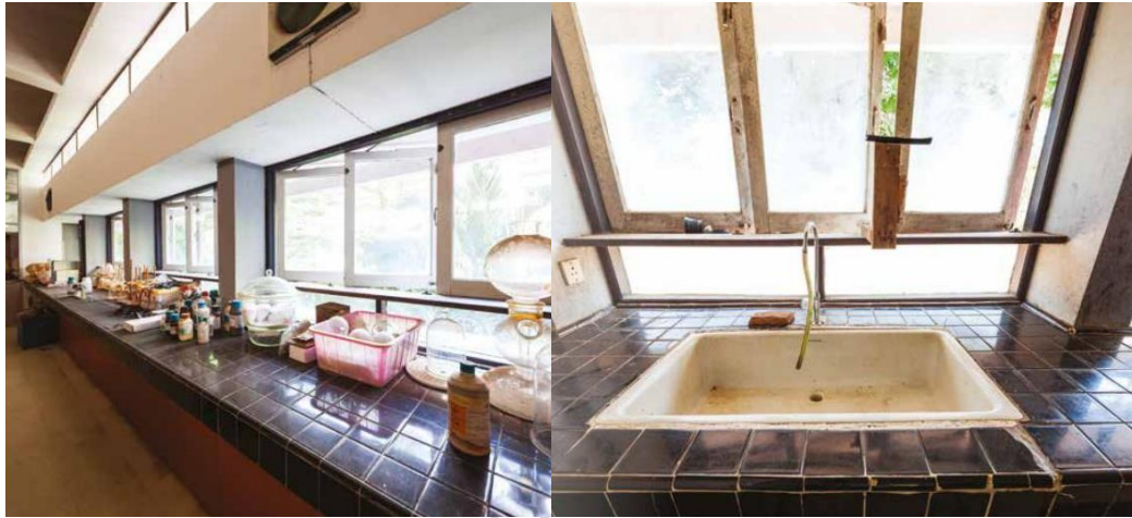
Figure 51 ภาพแสดงการใช้งานช่องแสงในการนำแสงธรรมชาติเข้ามาใช้งานบริเวณเคาน์เตอร์ทดลอง ที่มา (สิริเกียรติกุล 2563)
