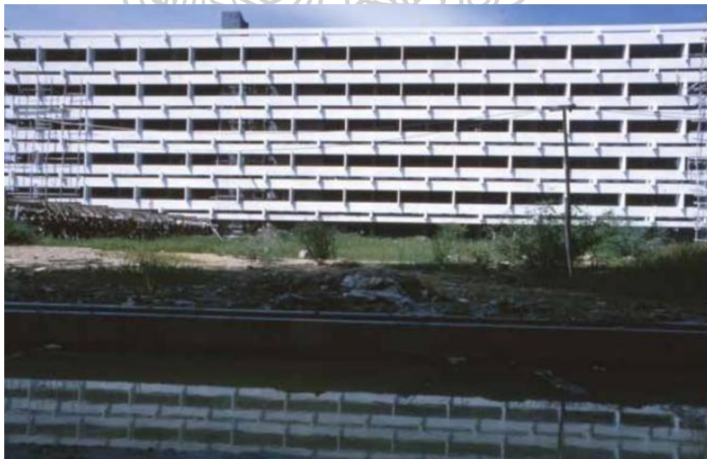
Figure 37 แผงกันแดดแนวตั้งและแนวนอนที่ได้ถูกนำมาใช้ตลอดแนวอาคารปฏิบัติการ ที่มา (สิริเกียรติกุล 2563)
