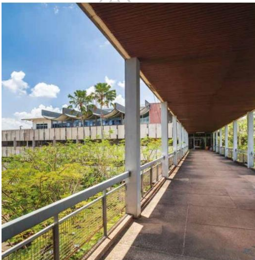
Figure 58 ภาพแสดง โถงทางเดินที่เปิดโล่งทำหน้าที่ในการเชื่อมต่ออาคารสู่อีกอาคาร ที่มา(สิริเกียรติกุล 2563)
