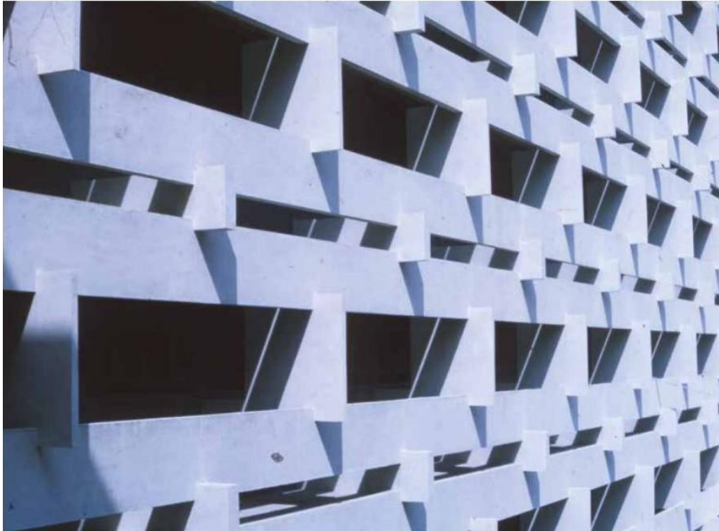
Figure 36 ภาพแสดงแผงกันแดดแนวตั้งและแนวนอนผ่านการ interlock กันในทุกๆระยะช่วงเสา 6 เมตร ที่มา (สิริเกียรติกุล 2563)
