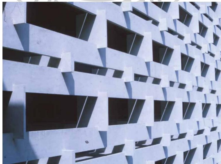
Figure 75 ภาพแสดงแผงกันแดดที่มีลักษณะการ interlock กัน ที่มา (สิริเกียรติกุล 2563)
