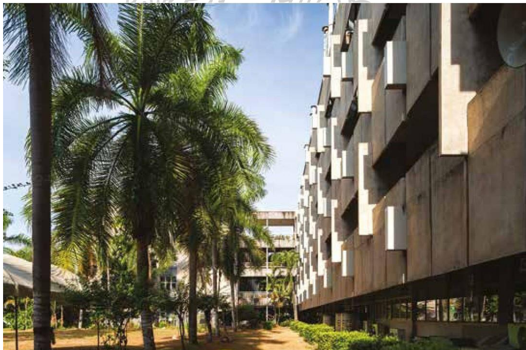
Figure 76 การเชื่อมต่อกันของแผงกันแดดแนวตั้งของอาคารคณะวิทยาศาสตร์ ที่มา (สิริเกียรติกุล 2563)
