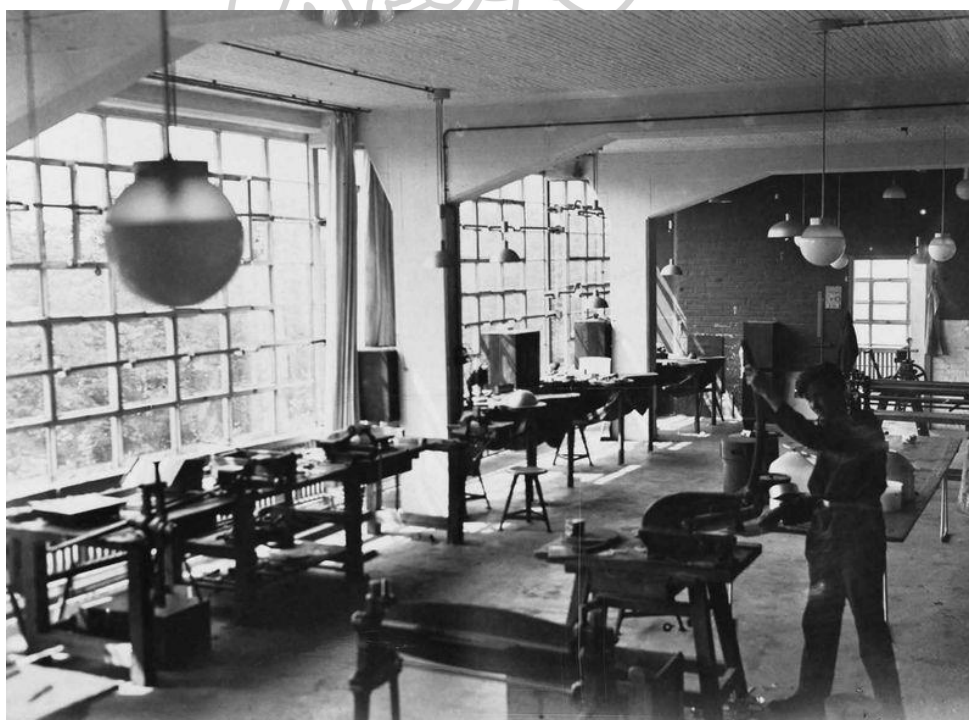
Figure 19 ภาพภายในอาคารส่วน Workshop block ที่สะท้อนให้เห็นแนวคิดในการออกแบบผนังกระจกเพื่อรับแสงจากภายนอกอาคาร ที่มา
