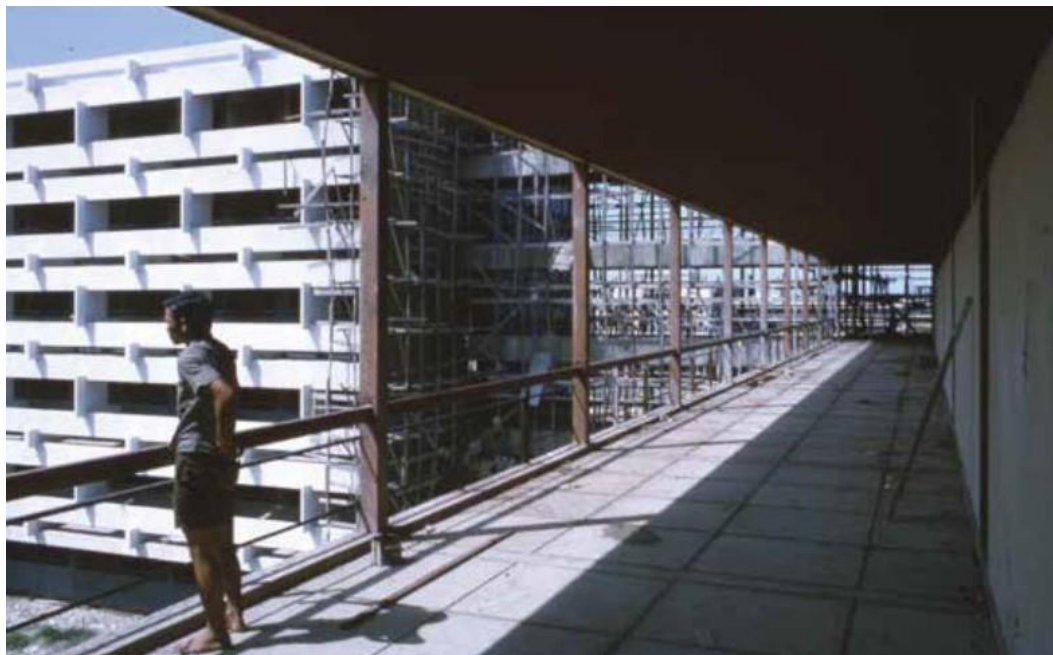
Figure 35 ภาพระหว่างการก่อสร้างตรงทางเดินภายในอาคาร ที่มีความกว้างอยู่ที่ 3 เมตร เพื่อป้องกันไม่ให้แสงแดดสาดเข้าสู่ภายในห้องปฏิบัติการได้โดยตรง ที่มา (สิริเกียรติกุล 2563)
