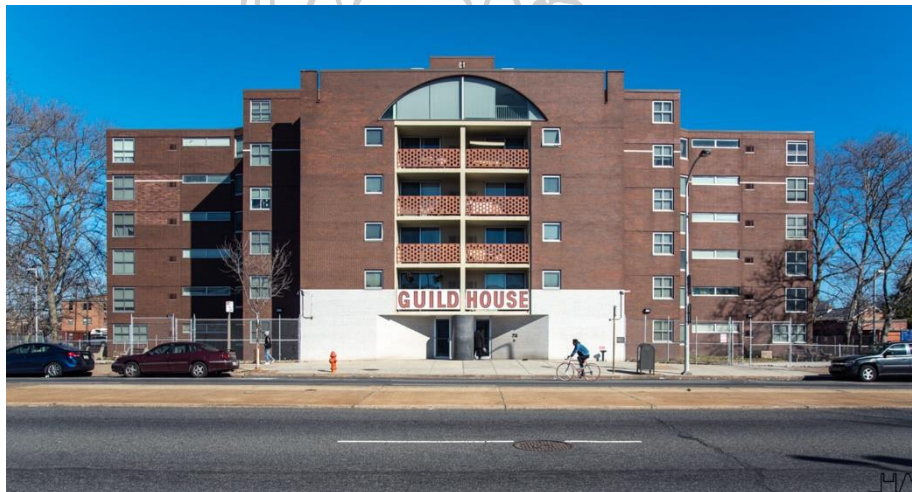
Figure 56 ภายนอกอาคาร Guild House แสดงถึงสัญลักษณ์ที่ต้องการจะสื่อ (Helena, 2017)
