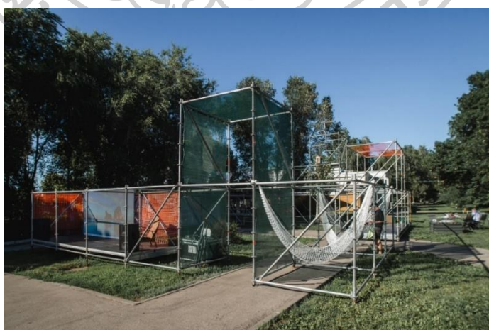
ภาพที่ 46 ภาพทัศนียภาพโครงการ Tretyakov Gallery Pavilion ที่มา : https://www.archdaily.com/965725/tretyakov-gallery-pavilion-linureau
