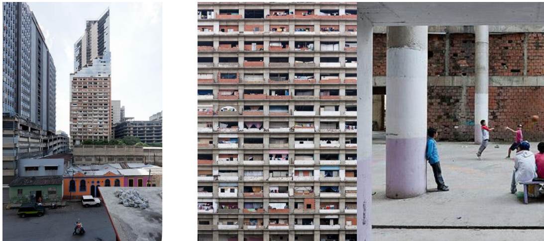
Figure 14 แสดงภาพภายนอกของอาคาร Torre de David
