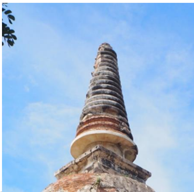
ภาพที่ 58 ปล้องไฉนของเจดีย์ทรงระฆังอยุธยาที่มีลักษณะเป็นลูกแก้วและมีเส้นลวดบัวขนานกับชั้นซ้อนลดหลั่นกันขึ้นไป เจดีย์วัดแม่นางปลื้ม จังหวัดพระนครศรีอยุธยา
