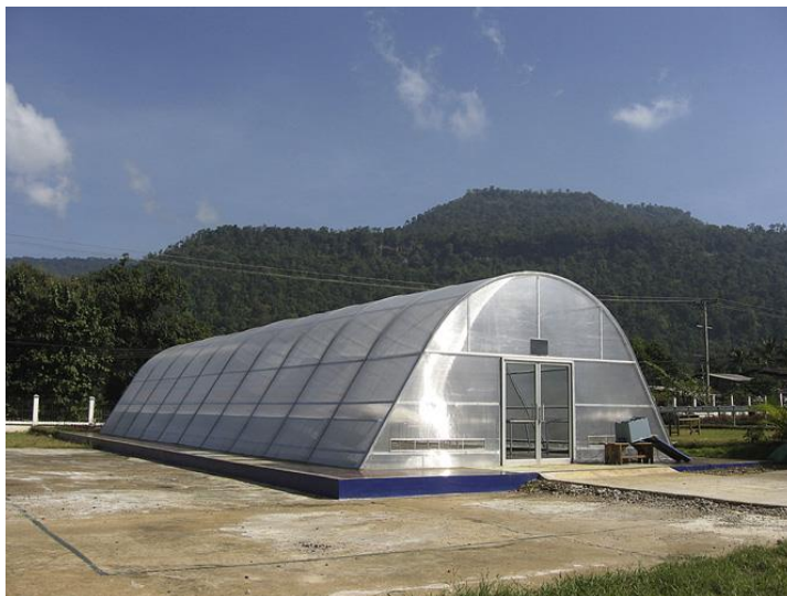
รูปที่ 29 เครื่องอบแห้งพลังงานแสงอาทิตย์ในสาธารณรัฐประชาธิปไตยประชาชนลาว (Janjai et al., 2011)
