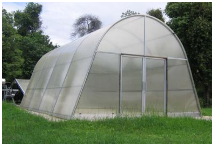
รูปที่ 28 เครื่องอบแห้งพลังงานแสงอาทิตย์แบบพาราโบลา (Janjai et al., 2009)
