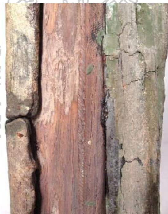
ภาพที่ 34 ด้านหลังที่มีไม้ที่ใช้สำหรับเสริมความแข็งแรงและรอยแตกกร้าว ที่มา : ภาพจากเจ้าหน้าที่พิพิธภัณฑสถานแห่งชาติ กรุงเทพมหานคร
