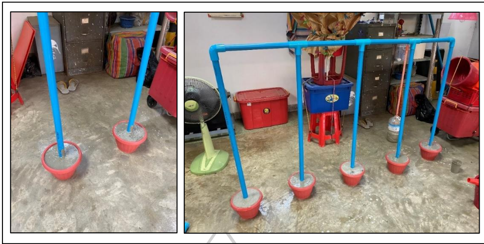
ภาพที่ 57 ภาพขั้นตอนการประกอบท่อ PVC เข้ากับกระถางต้นไม้ด้วยวิธีการเทปูนซีเมนต์เพื่อเพิ่มความมั่นคงและแข็งแรง ที่มา ผู้วิจัย
