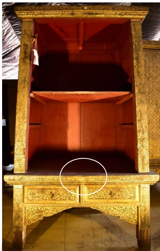
รูปที่ 6 ตู้สว. 11 บานประตูตู้ที่หายไป
