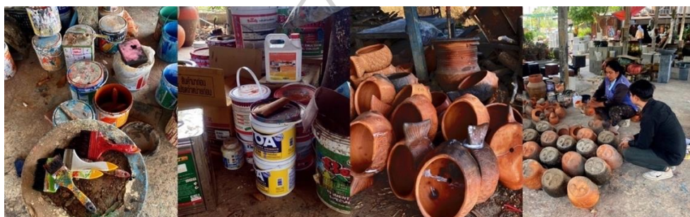
ภาพที่ 52 การซ่อมแซมและปิดรอยแตกร้าวของผลิตภัณฑ์ ด้วยวิธีการยาแนวและทาสีทับ
