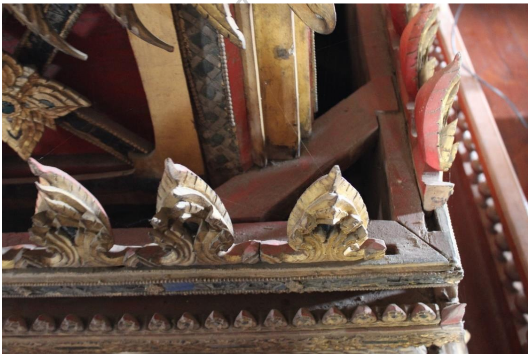
ภาพที่ 37 ตัวอย่างการเข้ามูไม้ การทำโครงสร้าง และการทำลายประกอบ จากธรรมาสน์วัดยาง จังหวัดเพชรบุรี
