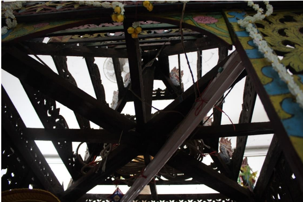
ภาพที่ 38 การศึกษาโครงสร้างภายในของการทำโครงสร้างชั้นหลังคาหรือเครื่องยอดแบบพื้นบ้าน ธรรมาสถ์วัดสุทธาราม จังหวัดร้อยเอ็ด ที่มา : ภาพถ่ายโดย อานุกาฬ จันทรัมย์พร (2562)
