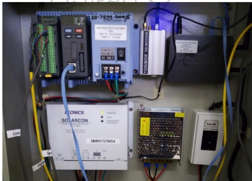
รูปที่ 46 เครื่องบันทึกข้อมูลของบริษัท Yokogawa รุ่น GM10 ที่สถานีอุตุนิยมวิทยานครราชสีมา
