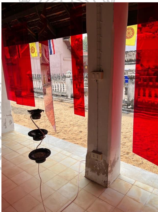
ภาพที่ 162 ชุดลำโพงขยายเสียงภายในศาลาบาตรที่สามารถกระจายเสียงได้ทั่วทั้งพื้นที่ ที่มา: ภาพประกอบเนื้อหาโดยรสลิน กาสต์
