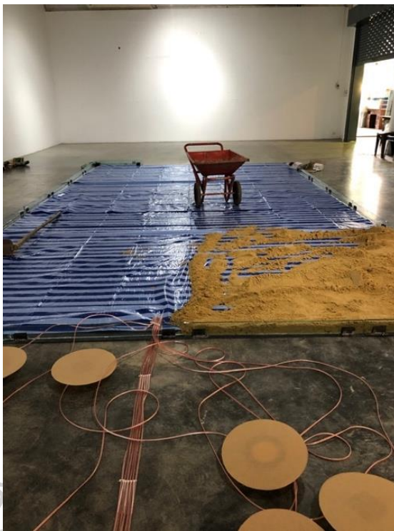
ภาพที่ 48 ขั้นตอนการบรรจุทรายลงในพื้นที่ ในภาพแสดงโครงสร้างเหล็ก กรอบแผ่นกระจกใส และระบบเครื่องขยายเสียงที่เตรียมไว้
