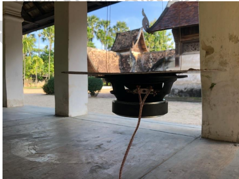
ภาพที่ 68 รายละเอียดของลำโพงขยายเสียง และวิธีการติดตั้งในศาลาบาตร
