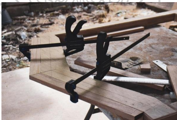
ภาพที่ 62: ภาพขั้นตอนการสร้างโครงสร้างส่วนจั่วหลังคาด้านหลัง เพิ่มขนาดหน้าไม้แนวนอน ที่มา: รูปถ่ายส่วนตัว
