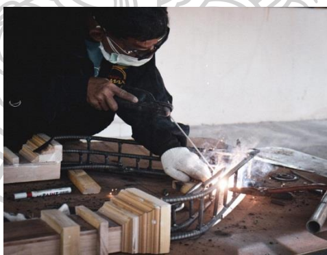
ภาพที่ 104: การประกอบโครงสร้างเหล็ก ที่มา: รูปถ่ายส่วนตัว
