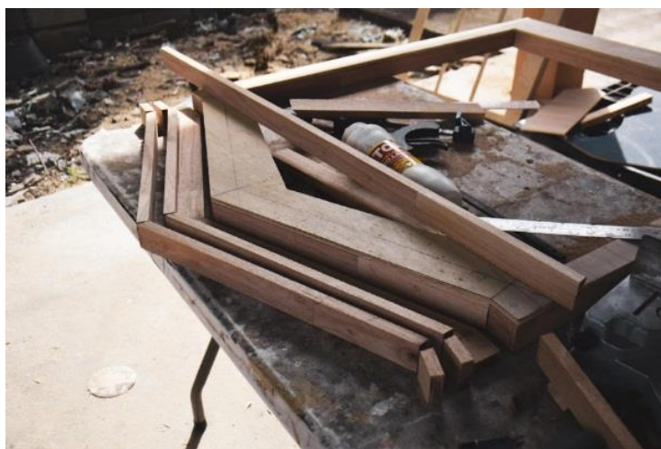
ภาพที่ 61: ภาพขั้นตอนการสร้างโครงสร้างส่วนจั่วหลังคาด้านหลัง ที่มา: รูปถ่ายส่วนตัว
