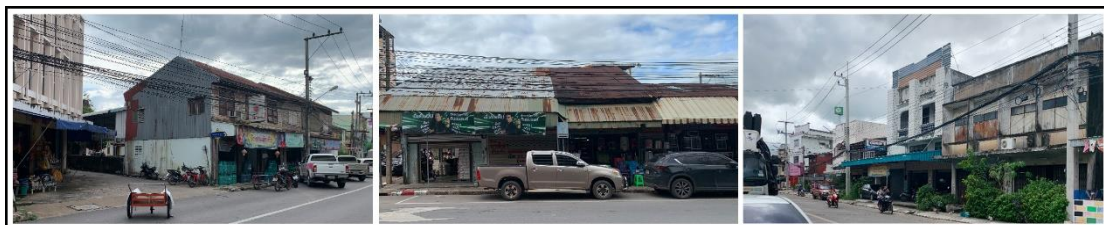
รูปที่ 56 ความทรุดโทรมของอาคารและสิ่งก่อสร้าง
